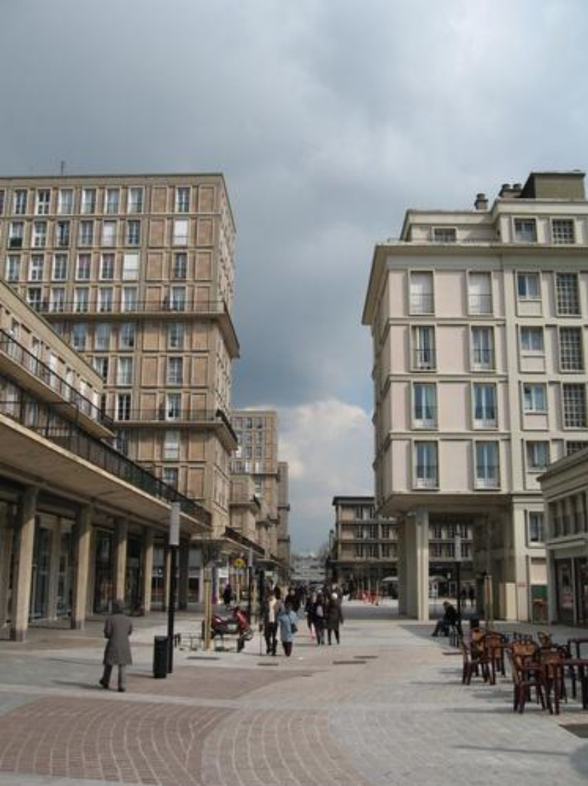
О.Перре. Центр Гавра. Южная сторона Площади Ратуши. Ратуша.
