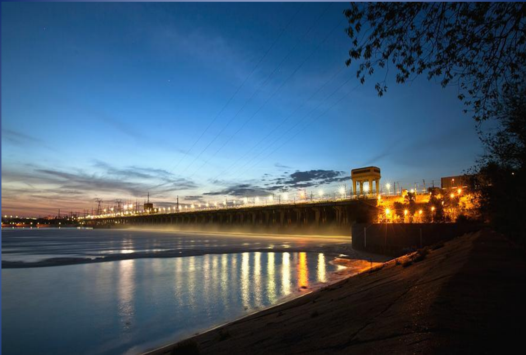
Волжская ГЭС — средненапорная гидроэлектростанция на реке Волге в Волгоградской области, в городе Волжском. Крупнейшая гидроэлектростанция в Европе.
