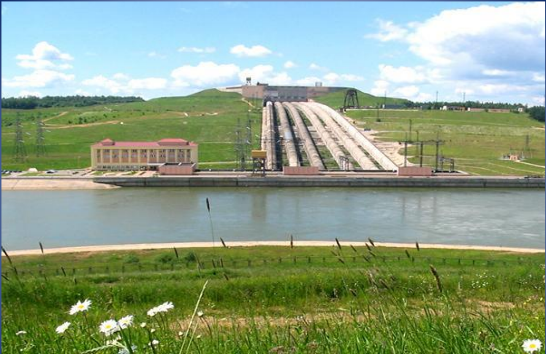
Загорская ГАЭС гидроаккумулирующая электростанция на реке Кунье у посёлка Богородское в Сергиево-Посадском районе Московской области.
