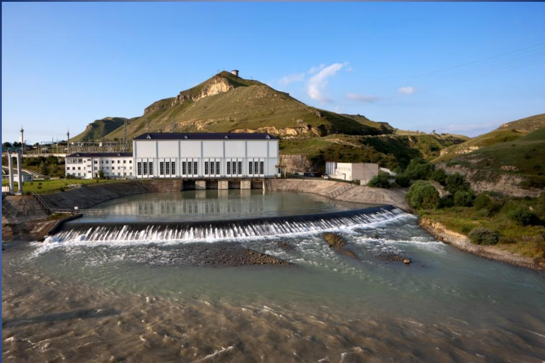
Зеленчукская ГЭС деривационного типа расположена в Северо-Кавказском Федеральном округе, Карачаево-Черкесская Республика, на территории Зеленчукского и Карачаевского районов.
