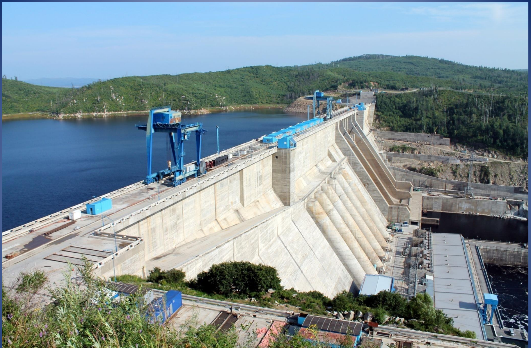
Бурейская высоконапорная ГЭС расположена на р. Буреe, в 280 км от г. Благовещенска, и предназначена для энергоснабжения промышленности Дальнего Востока.
