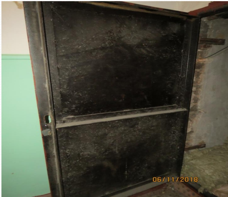
До начала работ
