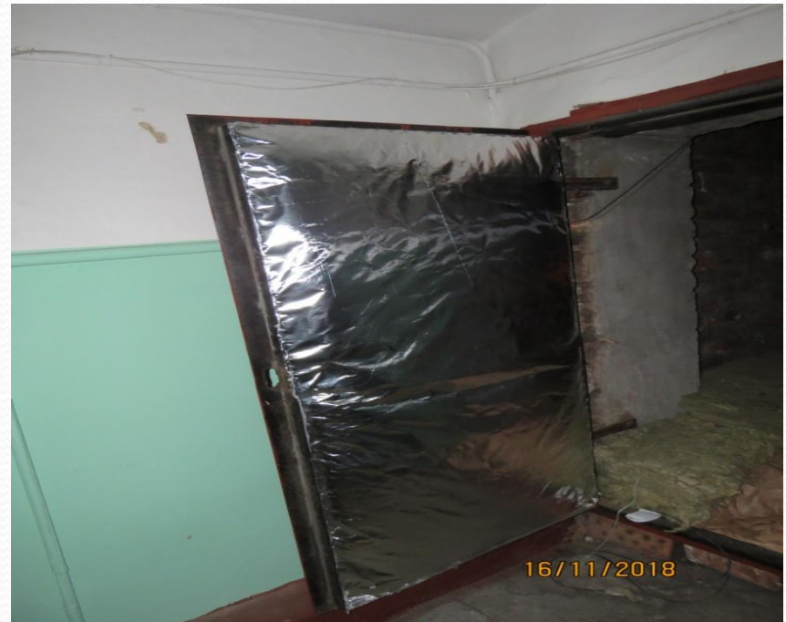
После завершения работ
