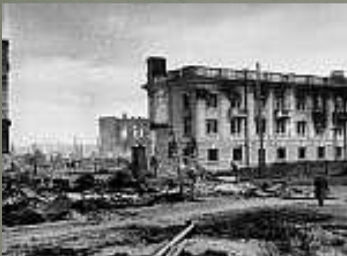
Разрушенная при отходе Красной Армии центральная часть Петрозаводска
