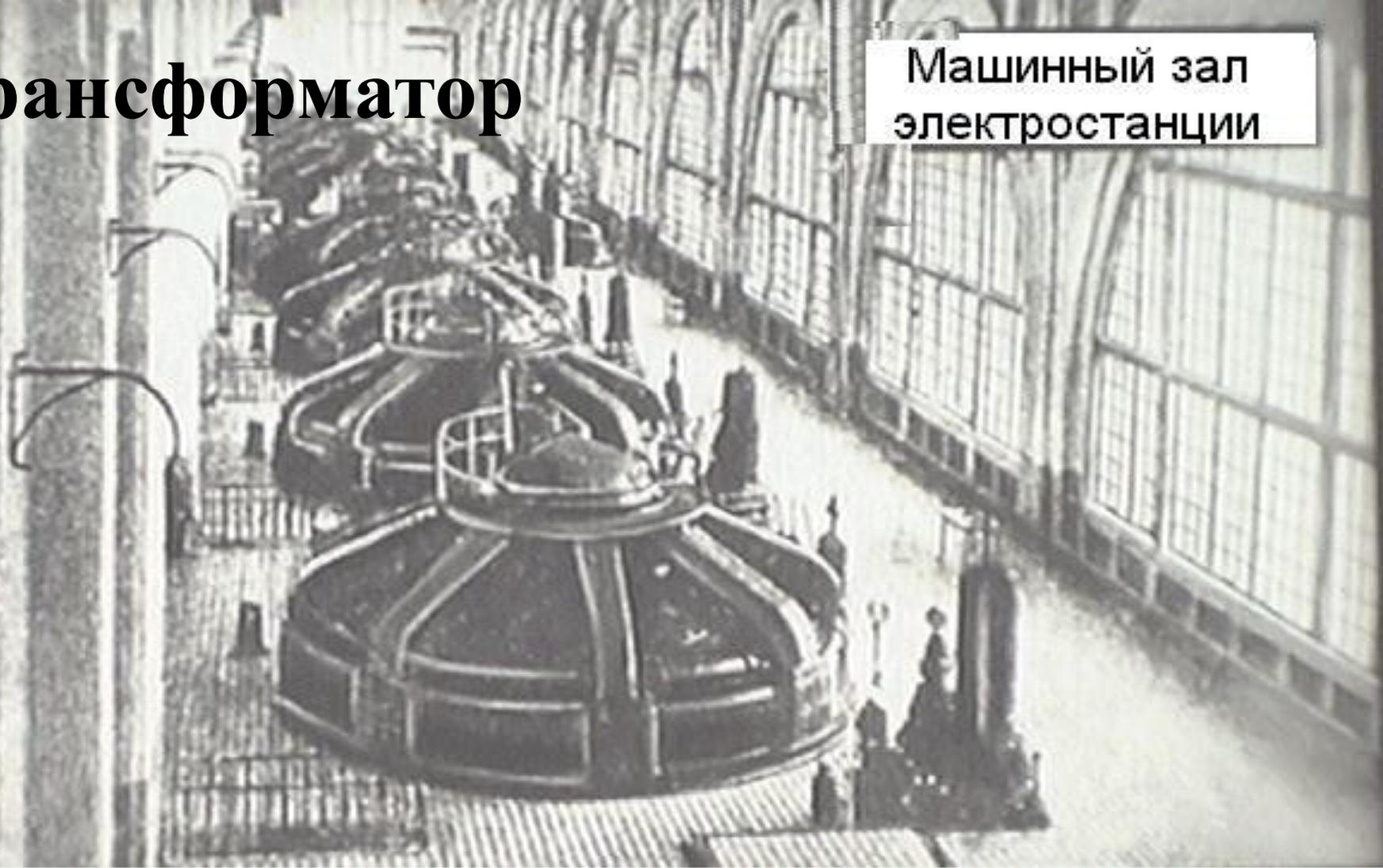
Современные электрические генераторы дают напряжение до 16 000 вольт. Передача энергии при таком напряжении на большие расстояния экономически нецелесообразна.
