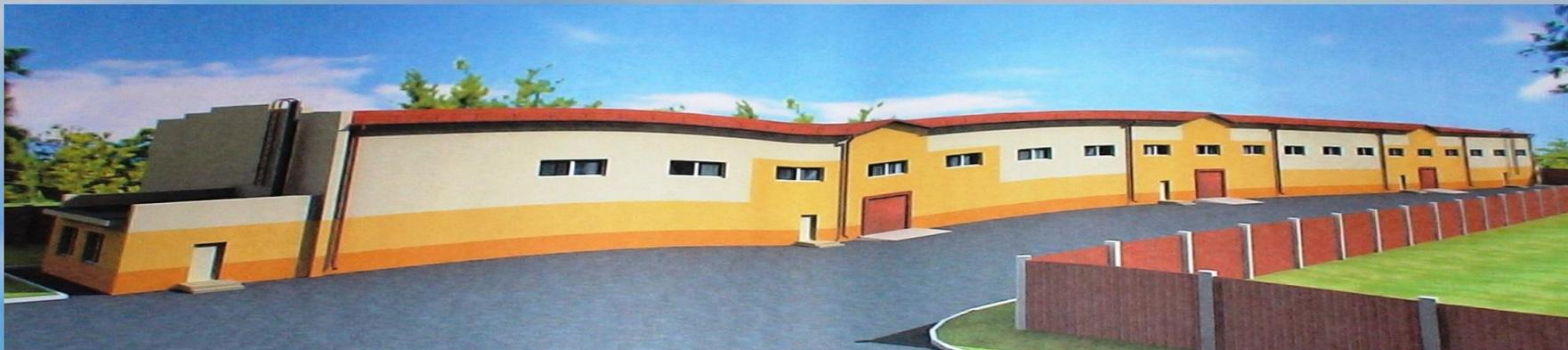
Промышленное одноэтажное здание размером 120м.х18м. х9,8м, оборудовано эл.снабжением, водоснабжением, канализацией, вентиляцией, отоплением, подвесным грузоподъемным краном грузоподъемность 3,2 т., высота до низа ферм покрытия – 7,2 м. Кровля скатная из профилированного металлического листа с утеплением. Подъездная автодорога с твердым покрытием.
