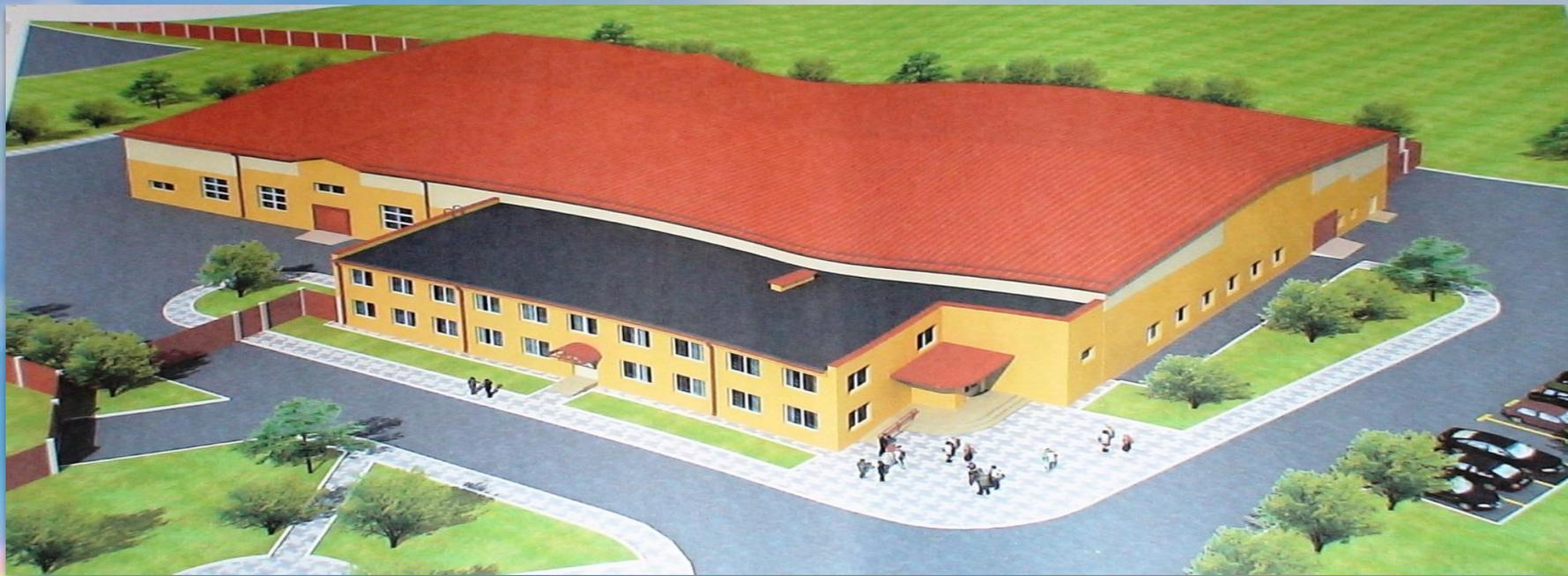
Промышленное одноэтажное здание размером 72м.х36м. х7,2м., оборудовано эл. снабжением, водоснабжением, канализацией, вентиляцией, отоплением, подвесными кран - балками - 3,2 т. Наружные стены из газосиликатных блоков с утеплением их «термошубой», фундаменты из монолитного железобетона.
