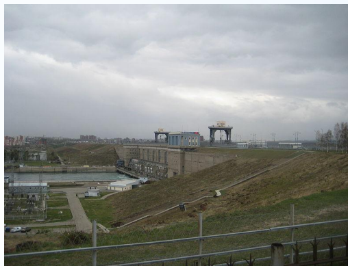
Иркутская ГЭС, р. Ангара (26 м)
