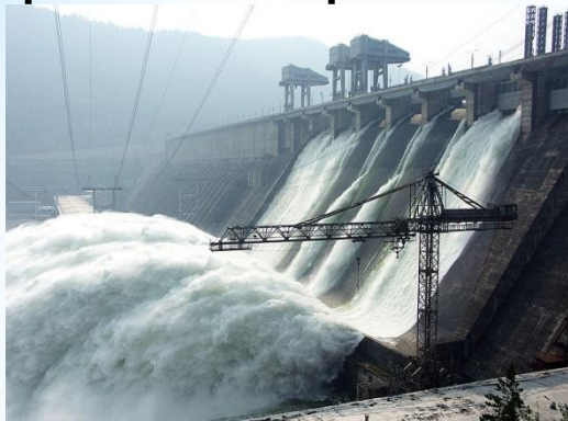
Красноярская ГЭС, р. Енисей (93 м)
