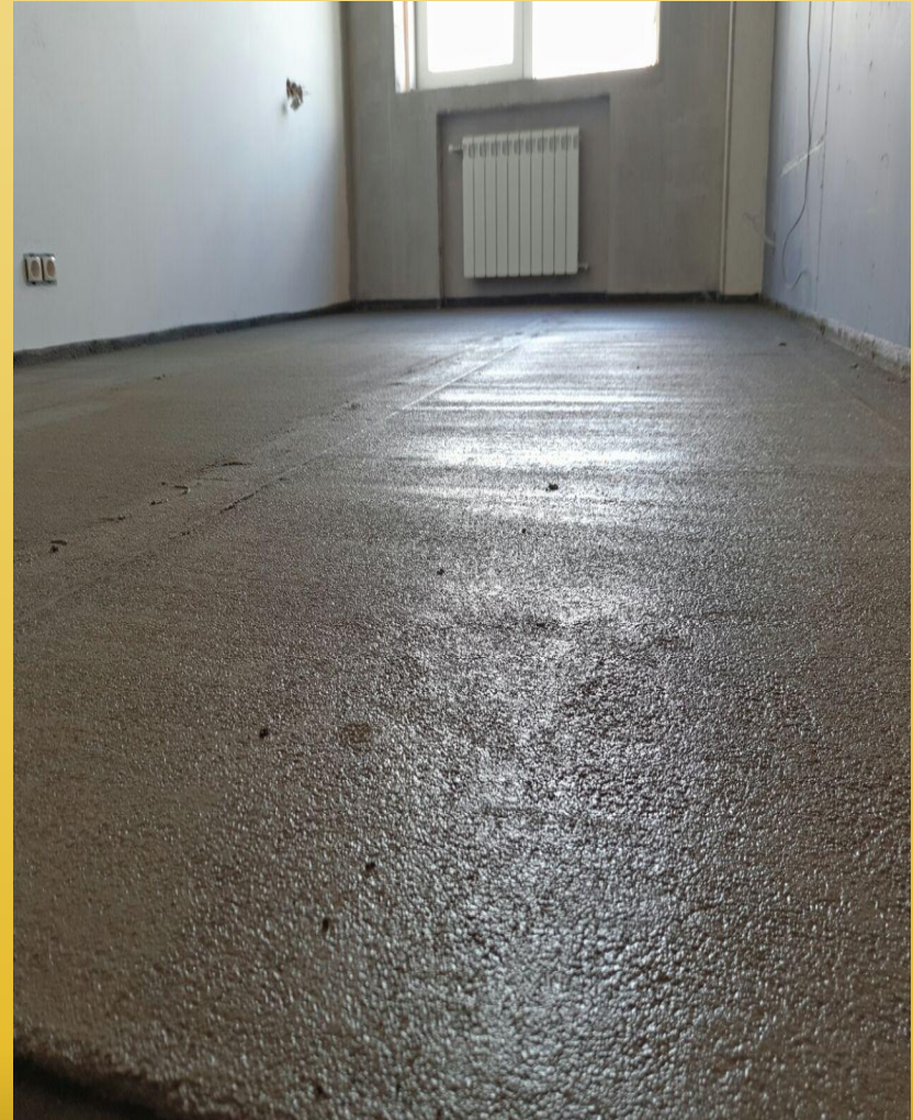
Заливка стяжки
