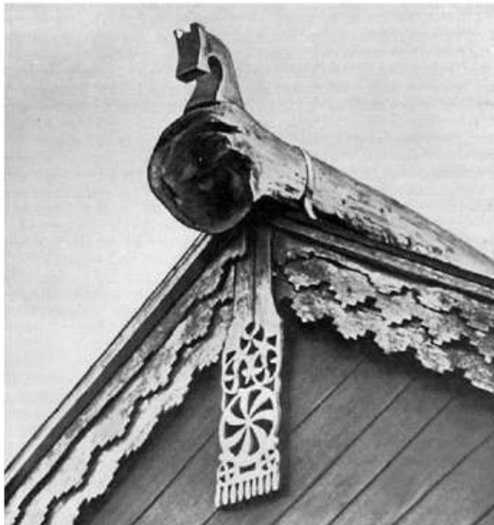
«ГРОМОВЫЙ ЗНАК» ПОД КОНЬКОМ КРЫШИ. Север
