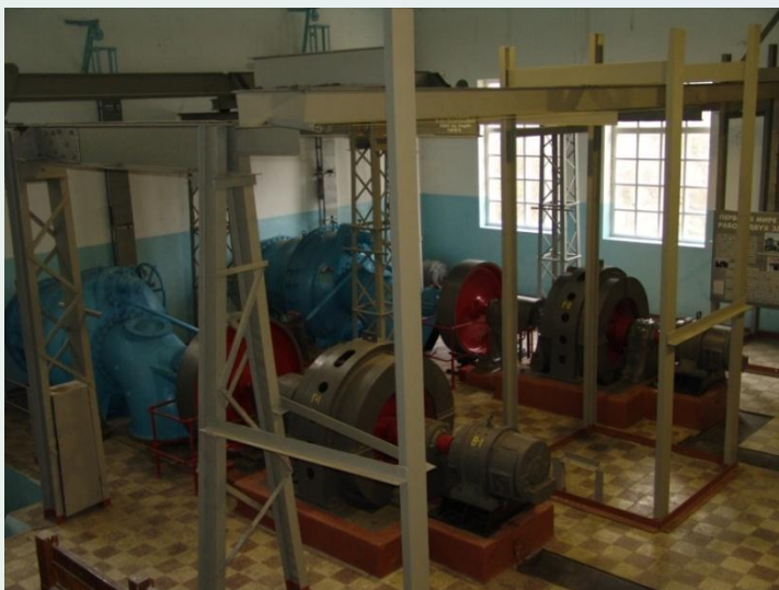
Гидроэлектростанция на реке Подкумок. Введена в действие в 1903 г. Установлены два генератора по 400 кВт.
