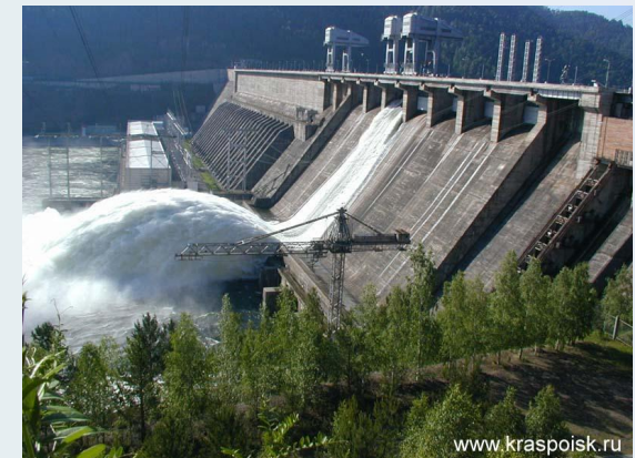
Плотина Красноярской ГЭС
