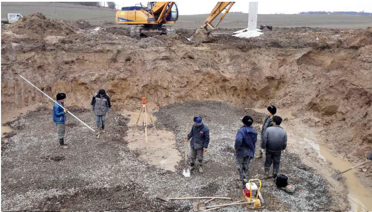
基础开挖 Разработка котлована под фундамент
