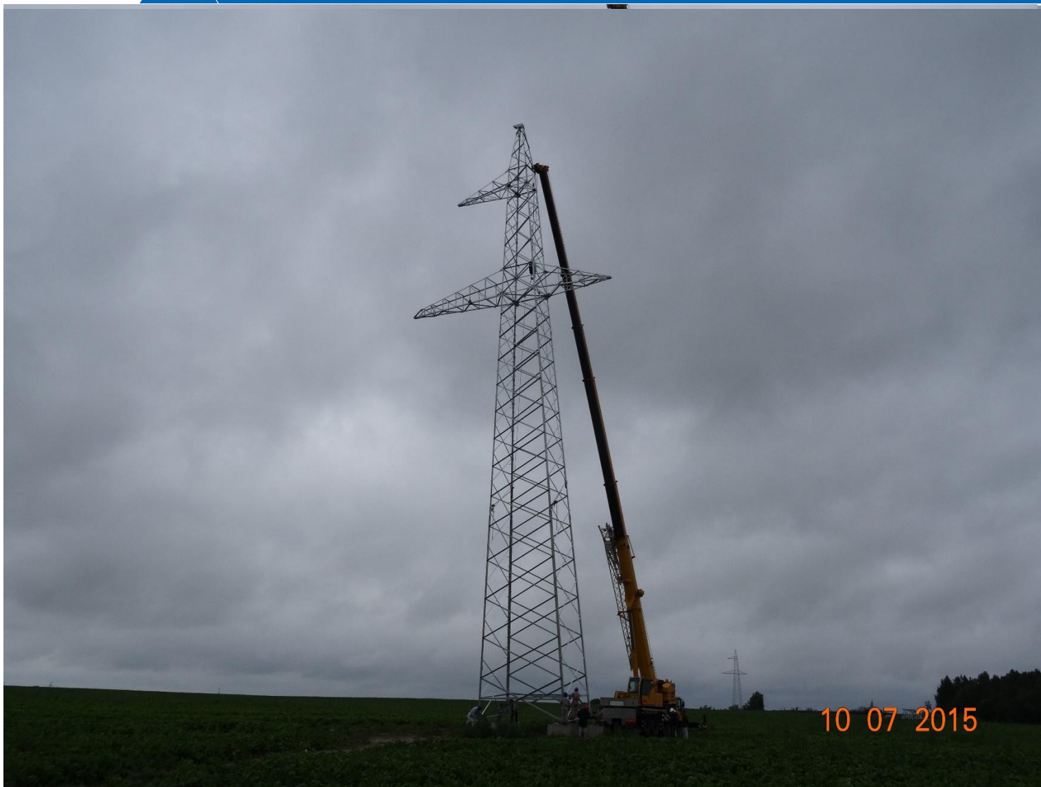
铁塔整体吊装 сборка и установка металлических опор
