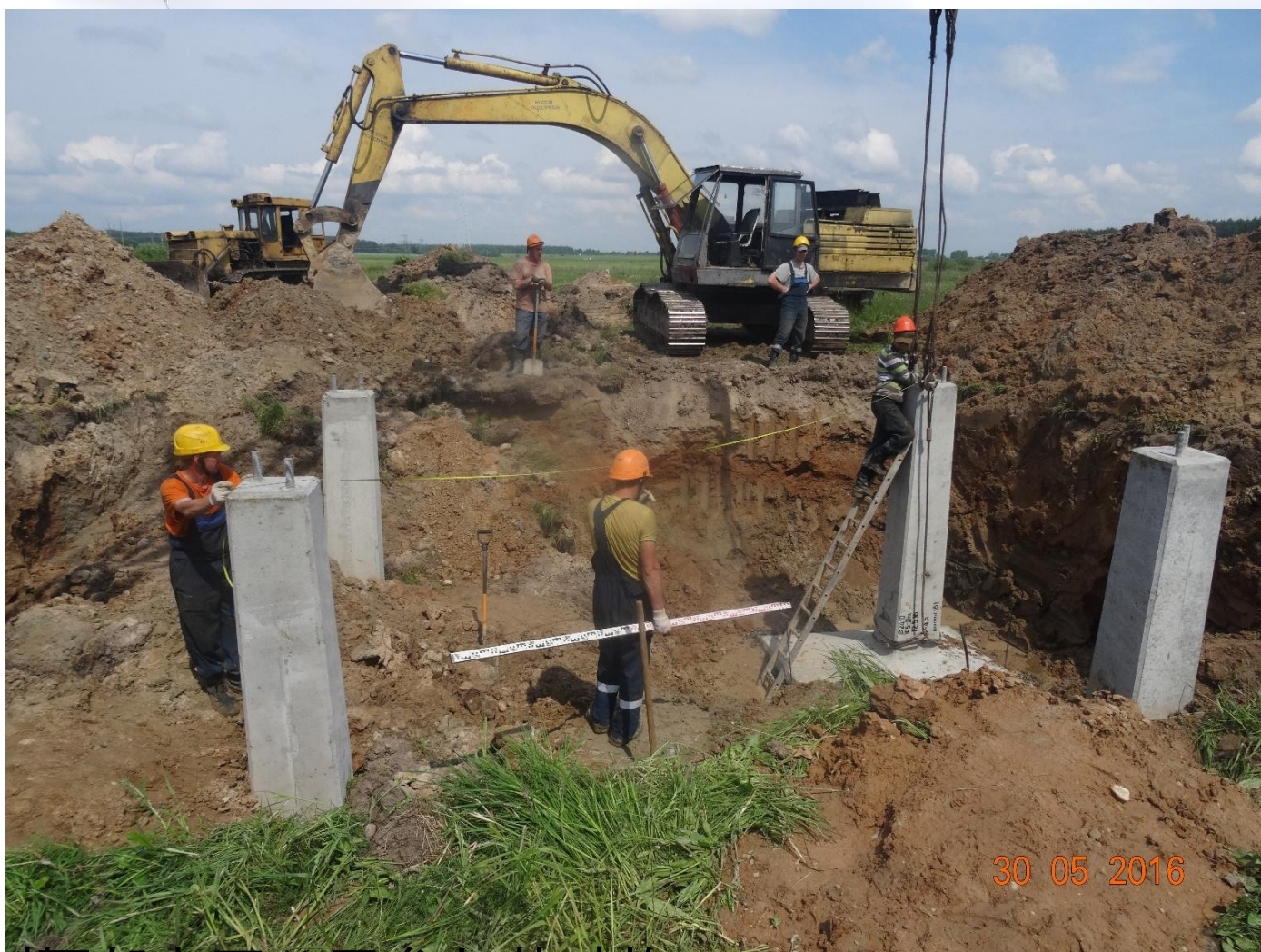
铁塔安装 西部电网公司参与基础施工
