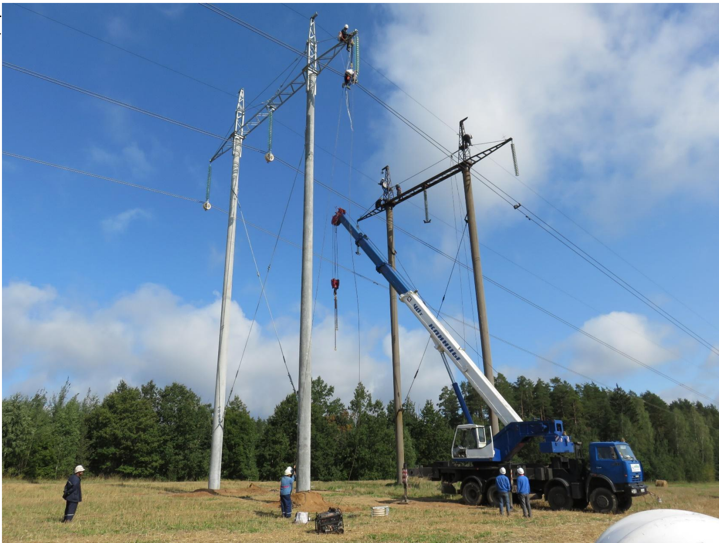
水泥杆更换工作 работа по замене железобетонных опор
