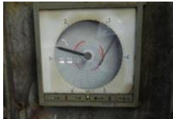
Вторичный прибор учета сжатого воздуха на участке адьюстажа
