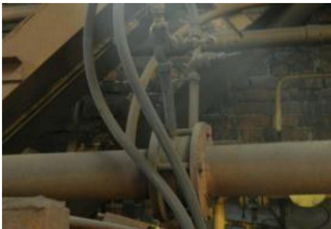
Первичный прибор учета сжатого воздуха на вводе в цех
