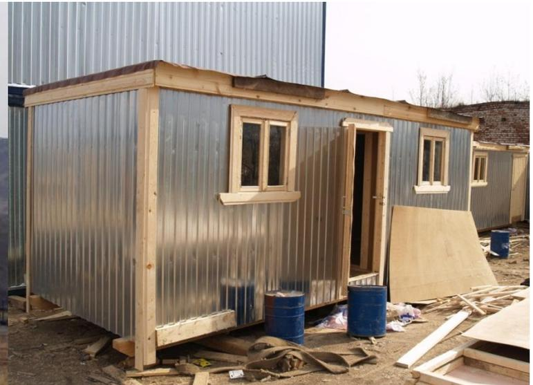
Ненадежный каркас делает невозможным возведение на основе блок-модулей кустарного производства модульных зданий.
