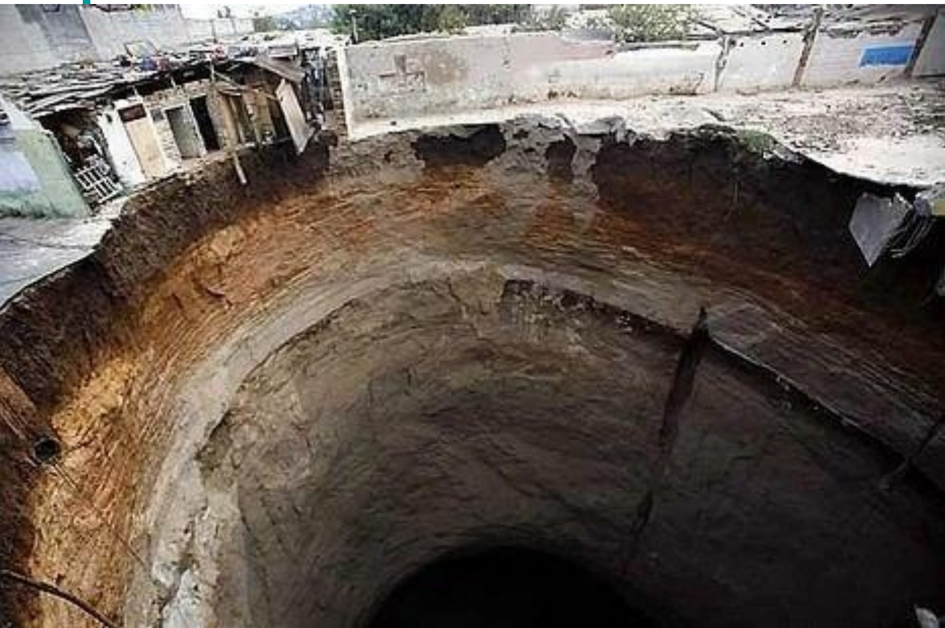
Карстовый провал в Гватемале. Вызван подземными водами и дождями.
