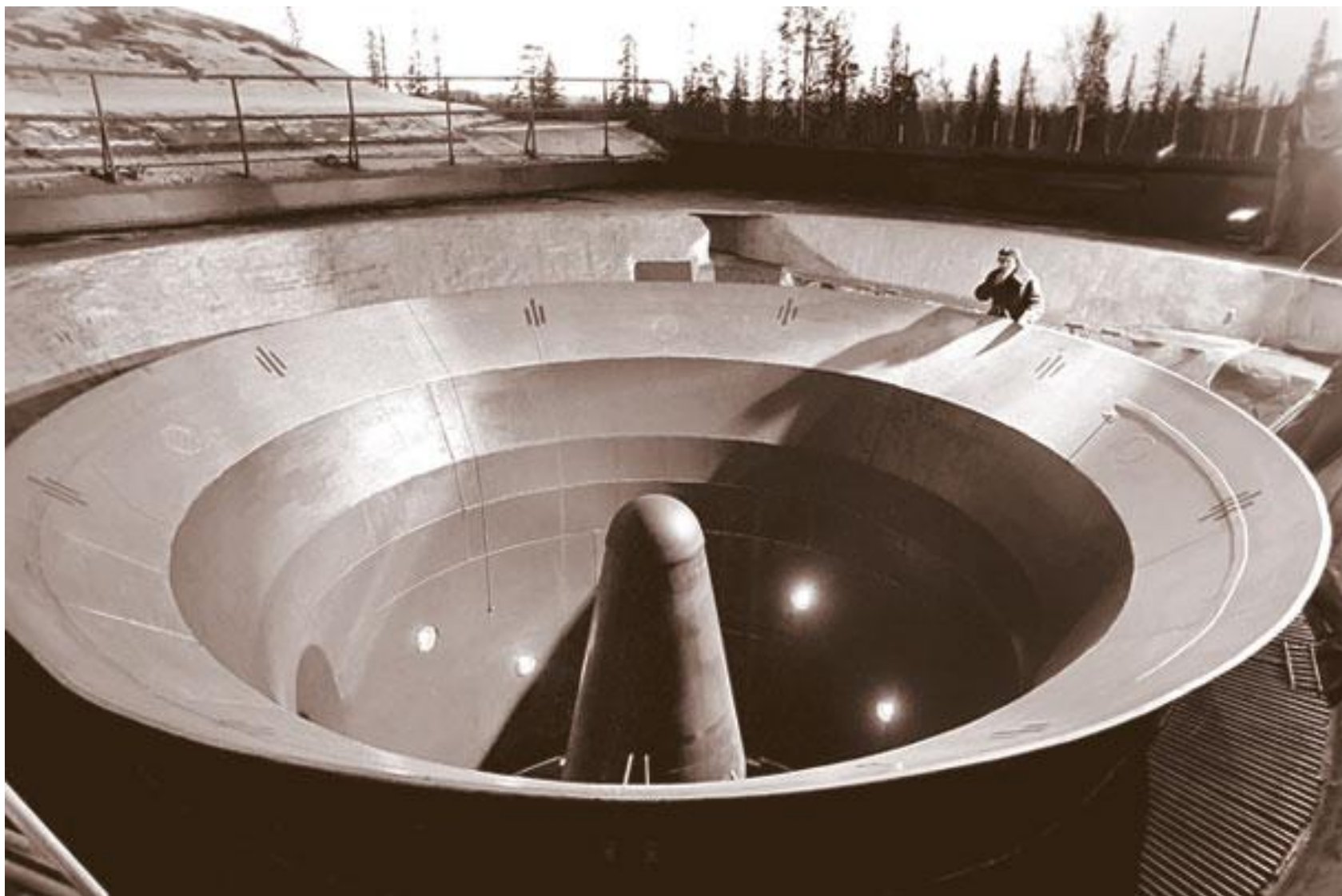
Ракета Р-14У установлена внутри ШПУ, защитная крыша сдвижного типа открыта, на проем газоотводящего тракта уложены площадки обслуживания
