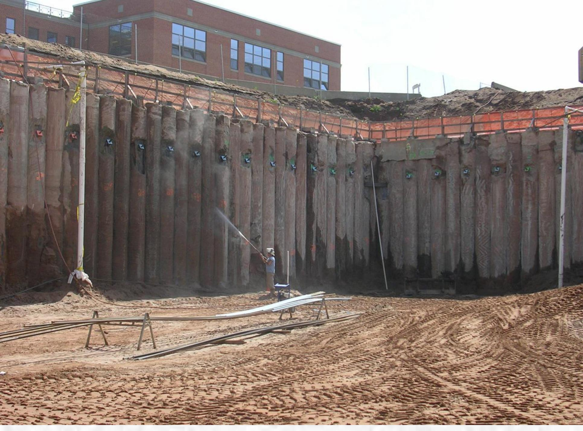
*Нагельное крепление – система внедренных в грунт армирующих стержней и образования защитного полотна над поверхностью стенки. В качестве нагеля используется арматура, для защитного слоя применяют мелкозернистый бетон, сборный железобетон.*
