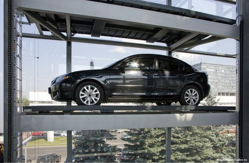
Рис. 5.1. Многоэтажный автомобильный паркинг, г. Москва
