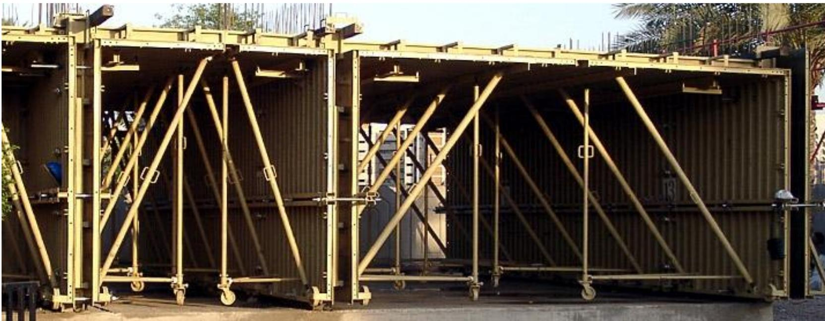
КОНСТРУКЦИЯ ОБЪЕМНО-ПЕРЕСТАВНОЙ ОПАЛУБКИ БЫЛА ПРЕДЛОЖЕНА И ЗАПАТЕНТОВАНА ВО ФРАНЦИИ В КОНЦЕ 1950-х гг. ОПАЛУБКА ПОЛУЧИЛА ФИРМЕННОЕ НАЗВАНИЕ «УТИНОР» ПО НАЗВАНИЮ АКЦИОНЕРНОГО ОБЩЕСТВА. УЖЕ ЧЕРЕЗ ГОД СИСТЕМА В АНГЛИИ БЫЛА УСОВЕРШЕНСТВОВАНА. В СЛЕДУЮЩИЕ ГОДЫ ТАКОЙ МЕТОД СТРОИТЕЛЬСТВА БЫЛ ПРИМЕНЕН В ШВЕЙЦАРИИ, ИСПАНИИ, ГОЛЛАНДИИ И ЗАТЕМ РАСПРОСТРАНИЛСЯ ВО ВСЕМ МИРЕ.
