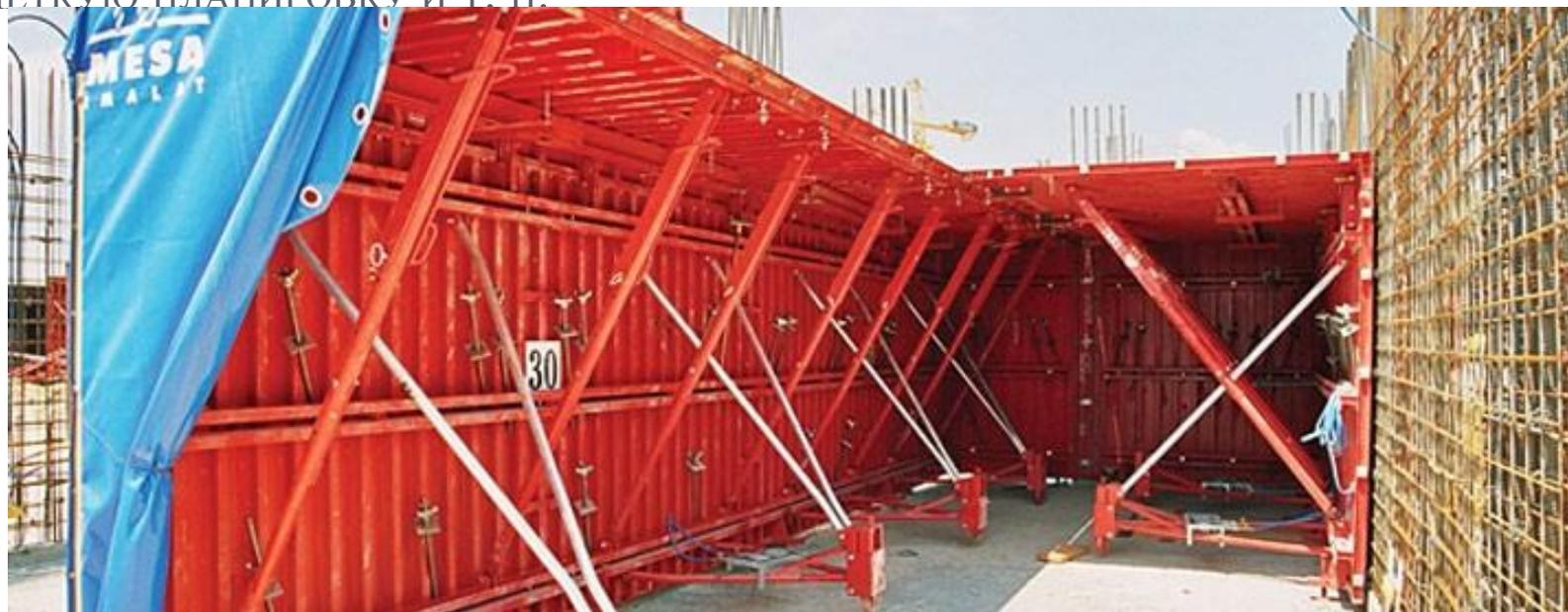
КРОМЕ ТОГО, ОБЪЕМНО-ПЕРЕСТАВНАЯ ОПАЛУБКА ИМЕЕТ БОЛЕЕ СЛОЖНУЮ, ЧЕМ КРУПНОЩИТОВАЯ, КОНСТРУКЦИЮ И БОЛЬШУЮ СТОИМОСТЬ. ПОЭТОМУ ПРИМЕНЯТЬ ЕЕ ЦЕЛЕСООБРАЗНО ДЛЯ ВОЗВЕДЕНИЯ БОЛЬШОЙ СЕРИИ МОНОЛИТНЫХ ЗДАНИЙ В ОДНОМ РАЙОНЕ С ВЫСОКИМ ТЕМПОМ ОБОРАЧИВАЕМОСТИ ОПАЛУБКИ.
