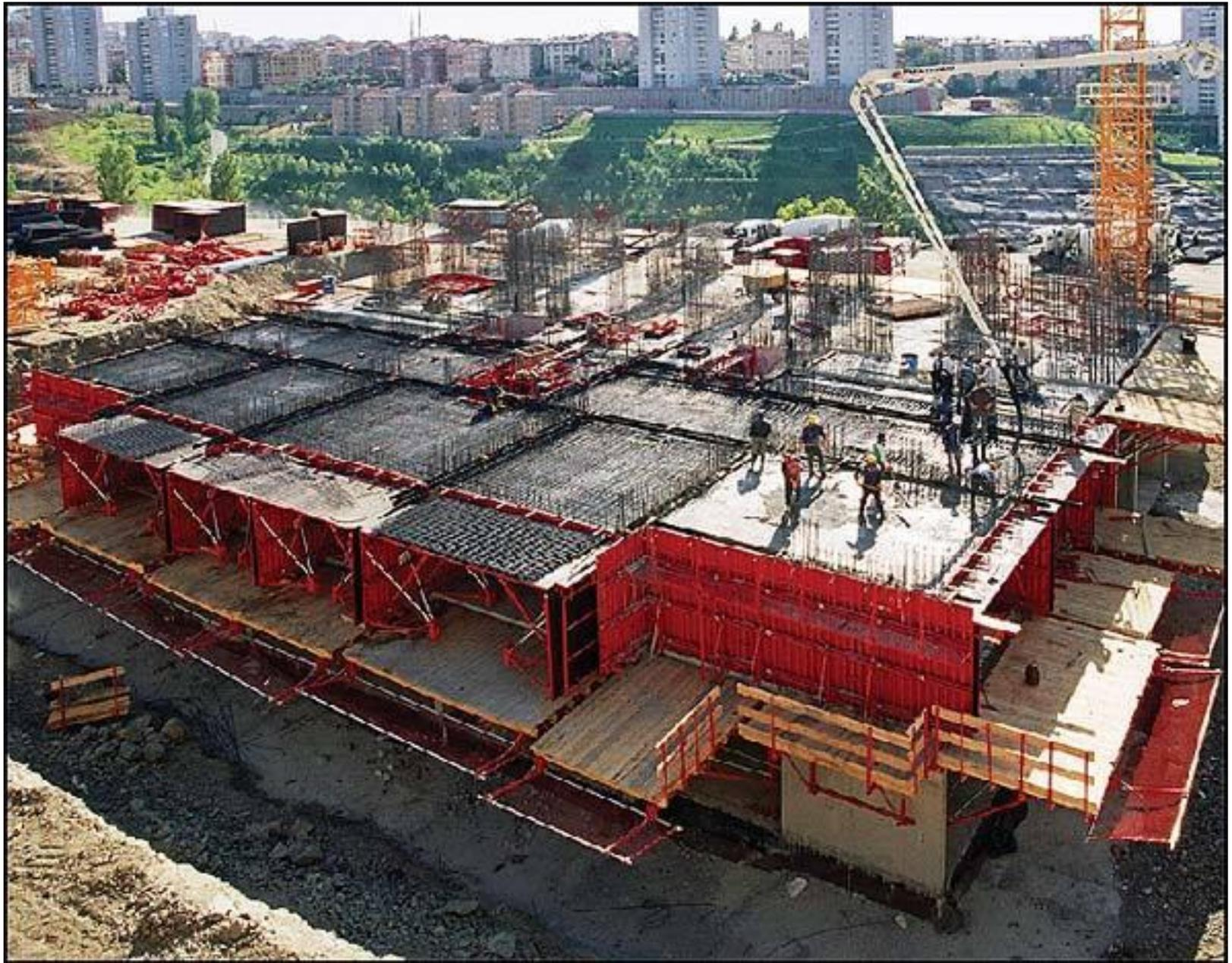
ВМЕСТЕ С ТЕМ ПРИМЕНЕНИЕ ОБЪЕМНО-ПЕРЕСТАВНОЙ ОПАЛУБКИ НАКЛАДЫВАЮТ ОПРЕДЕЛЕННЫЕ ТЕХНОЛОГИЧЕСКИЕ ОГРАНИЧЕНИЯ: НЕОБХОДИМО ОСТАВЛЯТЬ ПРОЕМЫ ИЛИ ОТКРЫТЫЕ ФАСАДЫ ДЛЯ ИЗВЛЕЧЕНИЯ ОПАЛУБКИ, ИМЕТЬ БОЛЕЕ ЧЕТКУЮ ПЛАНИРОВКУ И Т. П.
