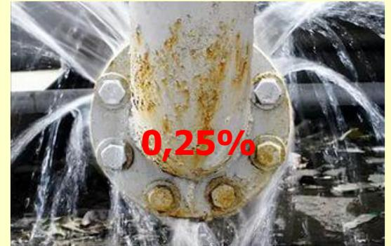
утечка теплоносителя не должна превышать 0,25% среднегодового объема воды в тепловой сети и присоединенных к ней системах теплоснабжения в час
