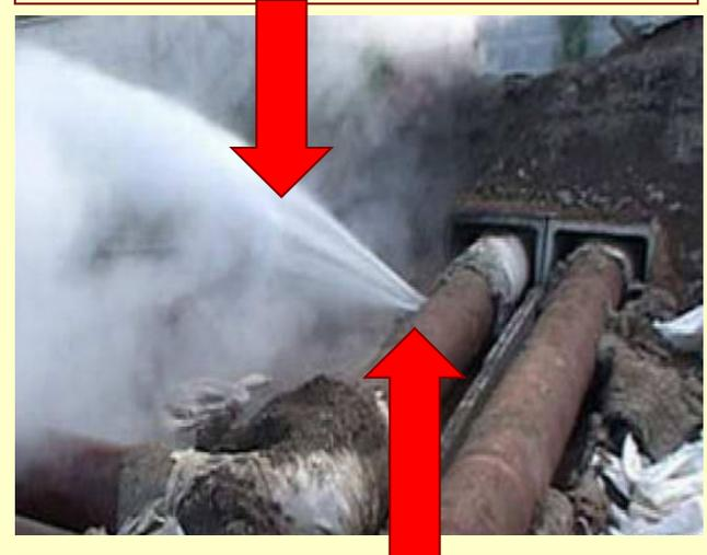
**Испытания на прочность и плотность для выявления дефектов не позже, чем через две недели после окончания отопительного сезона**
