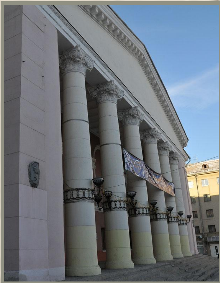
• Колоннада главного входа в здание театра опера и балета
