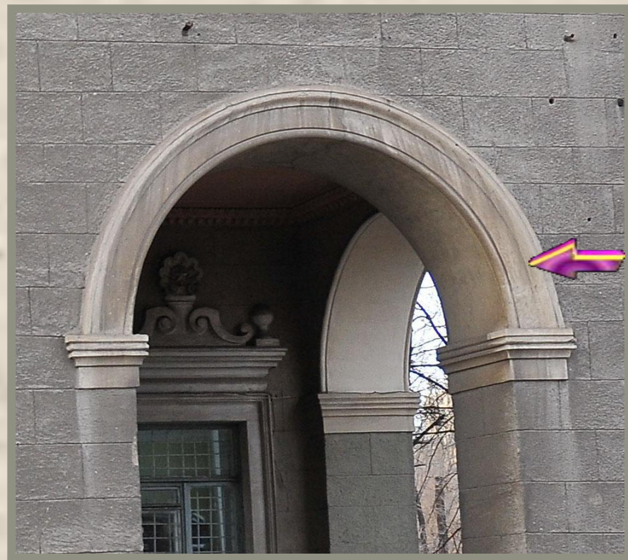
•Архивольт по пр.Металлургов 15
