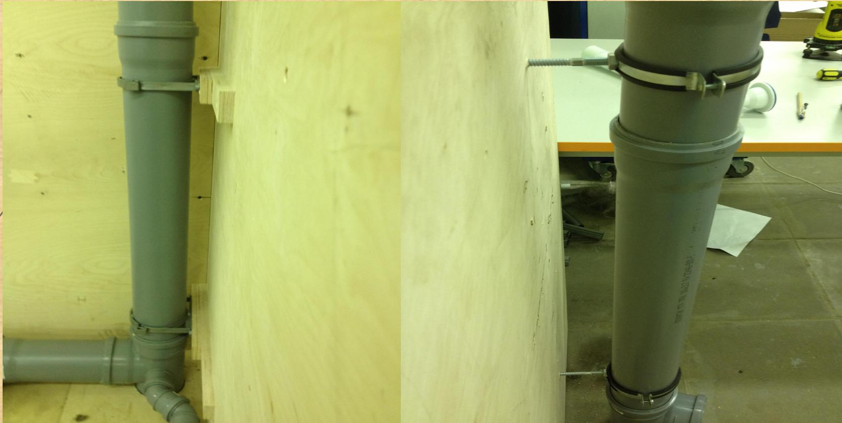
Этап 2: определение место установки приемников сточных вод и трассировка горизонтальных участков трубопровода
