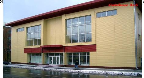
Металлический сайдинг широко используется для облицовки фасадов зданий общественного назначения, а также зданий промышленного назначения. Применяют стальной сайдинг и для специального строительства, где предъявляются повышенные требования по пожаробезопасности, коррозионной стойкости, устойчивости к агрессивным средам, и др
