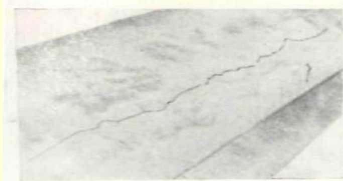
Рис. 180. Продольная трещина на поковке вала
