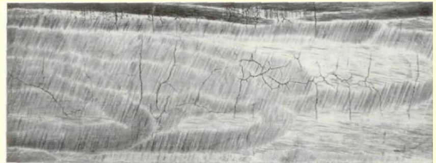
Рис. 74. Шлифовочные трещины на горячекатаной заготовке
