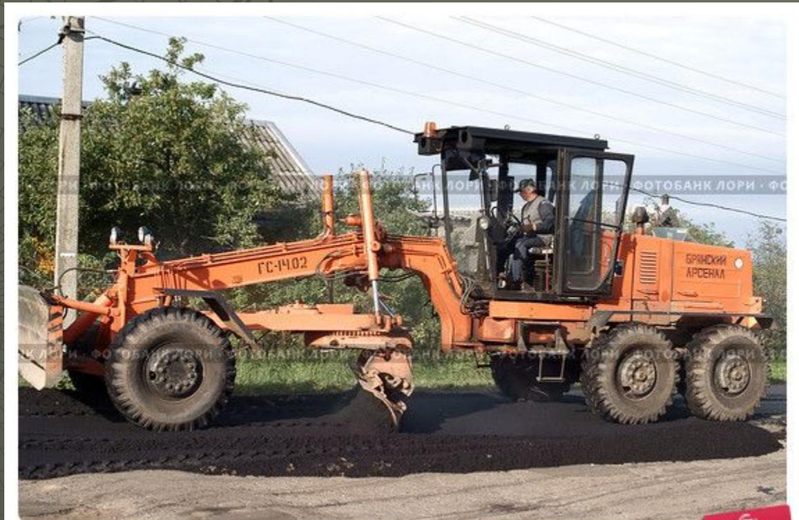
Ремонт автодороги. Разравнивание асфальтобетонной смеси автогрейдером GC-1402
