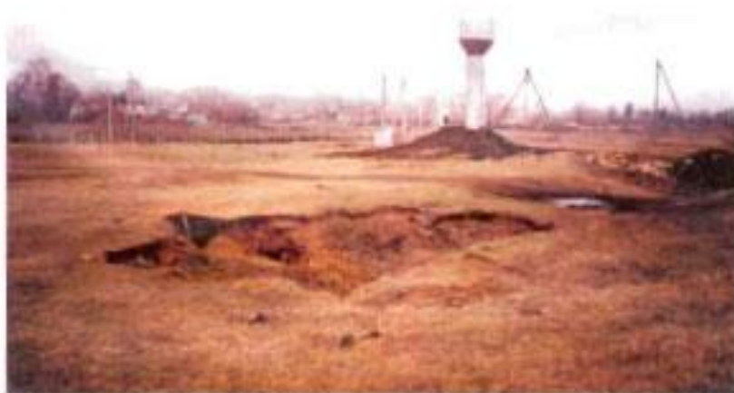
Рис. 2.22. Карстовый провал в с.Черкассы Елецкого района Пилецкой области
