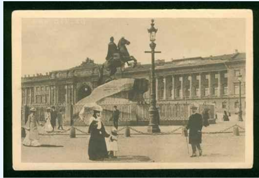
Здание Сената и Синода
