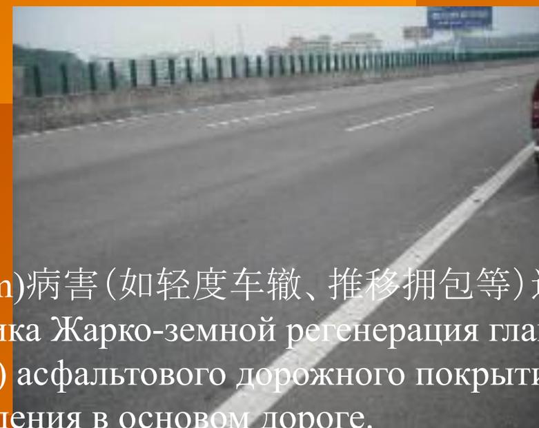
就地热再生是一种针对沥青路面面层出现的大面积浅层(不超过60mm)病害(如轻度车辙、推移拥包等)进行处治的措施,而且要求路面结构和路基坚固并具有良好的排水系统。Техника Жарко-земной регенерация главно заостряет внимание на поверхностный тонкий слой( не больше 60мм) асфальтового дорожного покрытия проходить ремонт. И это требуется иметь хорошую систему водоотведения в основном дороге.
