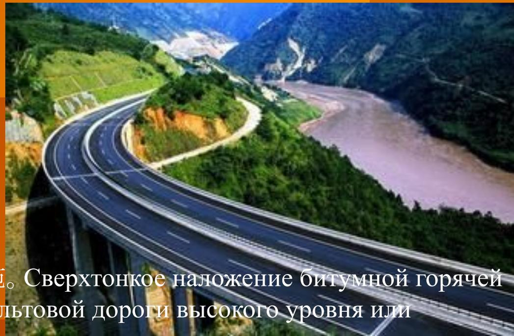
热拌沥青混合料罩面是一种高等级沥青路面的预防性养护措施。Сверхтонкое наложение битумной горячей битумной смеси является технологией для строительства асфальтовой дороги высокого уровня или профилактического обслуживания.
