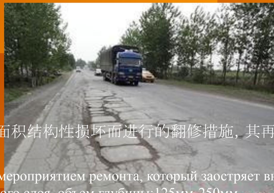
全深式就地冷再生是一种针对沥青路面面层及部分基层出现大面积结构性损坏而进行的翻修措施，其再生处治深度范围一般为125mm-250mm。
