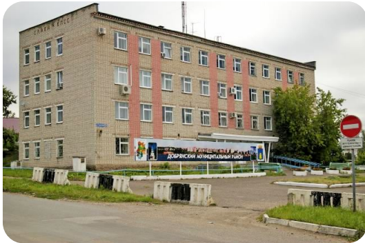
Здание администрации Добрянского муниципального района
