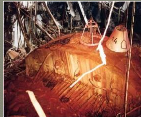
Крышка реактора после взрыва
