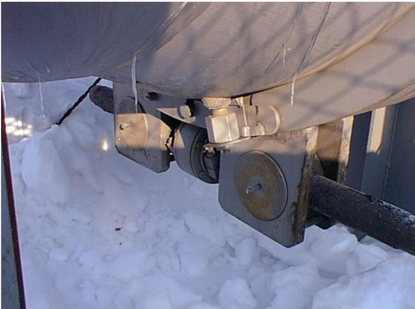
**В июле 2006 года при заполнении природным газом камеры запуска очистных устройств в Кунгурском ЛПУ МГ ООО «Пермтрансгаз» произошла авария – отрыв сферической крышки затвора модели ТА-М производства ОАО «Салаватнефтемаш, приведшая к человеческим жертвам.**
