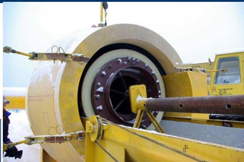
**Блок камер приема «Санема» снабжен защитным отбойником (экраном) для предотвращения попадания в зону открытия затвора камеры загрязнений, очистных и диагностических поршней.**
