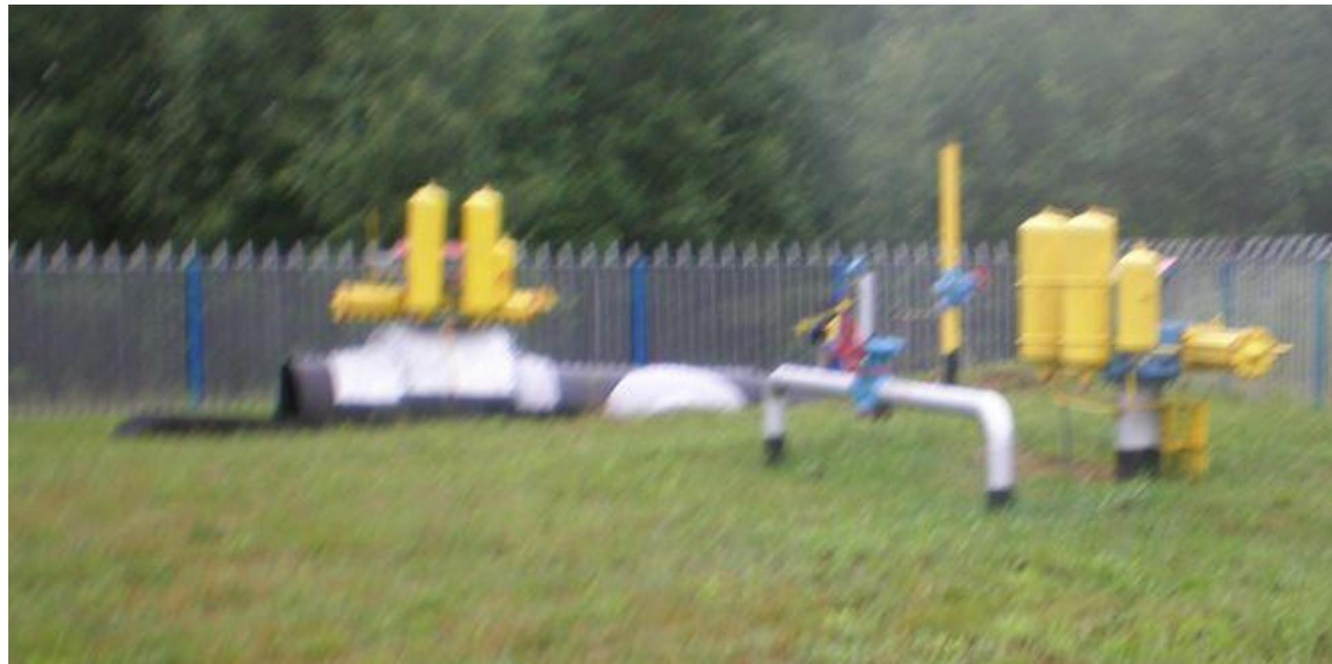
**«Блок камеры» запуска (приема) состоит из камеры запуска (приема), устройства запасовки (извлечения), крана консольного, сигнализатора поточных устройств и площадок обслуживания.**
