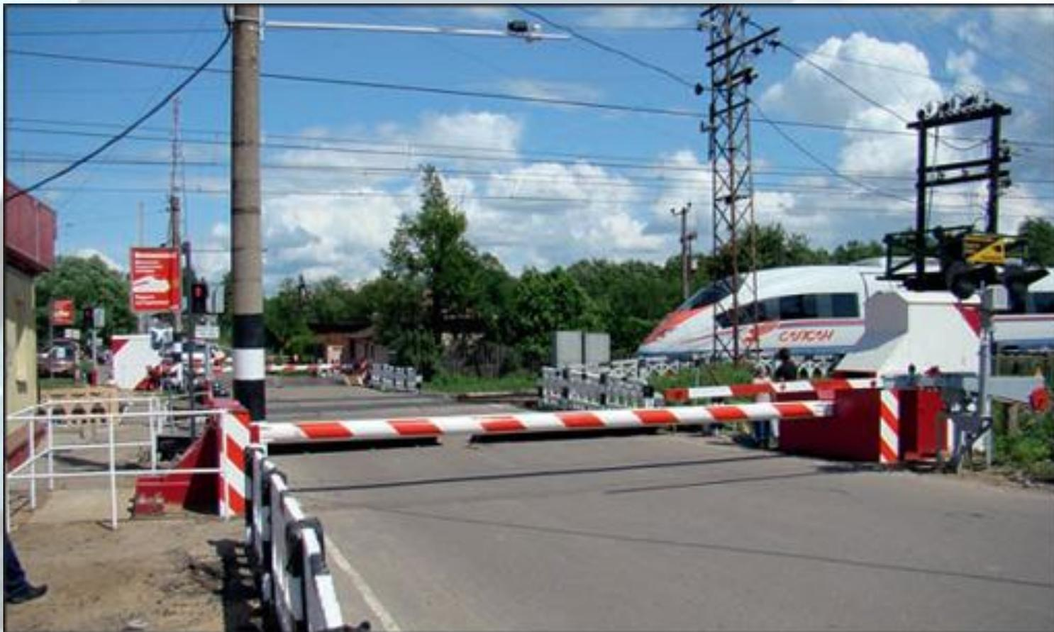
Рис. 1. Противотаранное устройстве шлагбаумного типа
