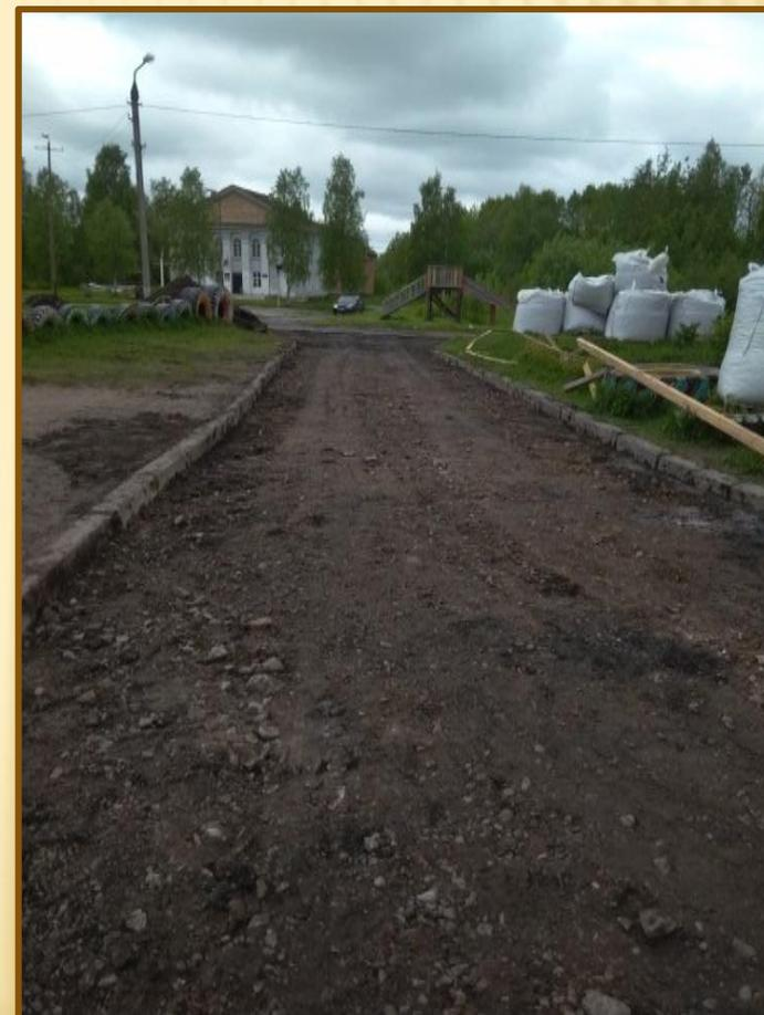
*Снятие деформированного асфальтового покрытия*
