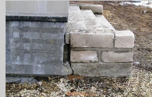
5. **ГОРИЗОНТАЛЬНЫЕ ПЕРЕМЕЩЕНИЯ** или **СДВИГ** сооружения- происходят под воздействием наклонных нагрузок, при размещении сооружения вблизи откосов, вследствие подземных подрботок.
