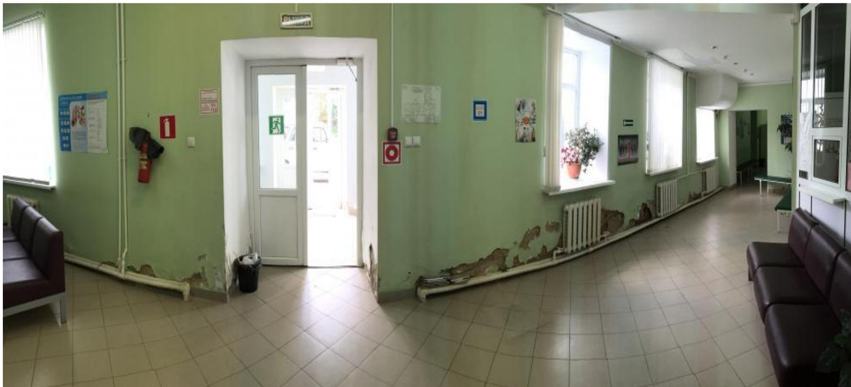
Наблюдение за состоянием здания ГУЗ ЯО «Угличская ЦРБ» ведёт с 2014 года. Осенью 2018 года состояние здания стало заметно ухудшаться. Установленные маяки начали рваться и отделяться от стен.
