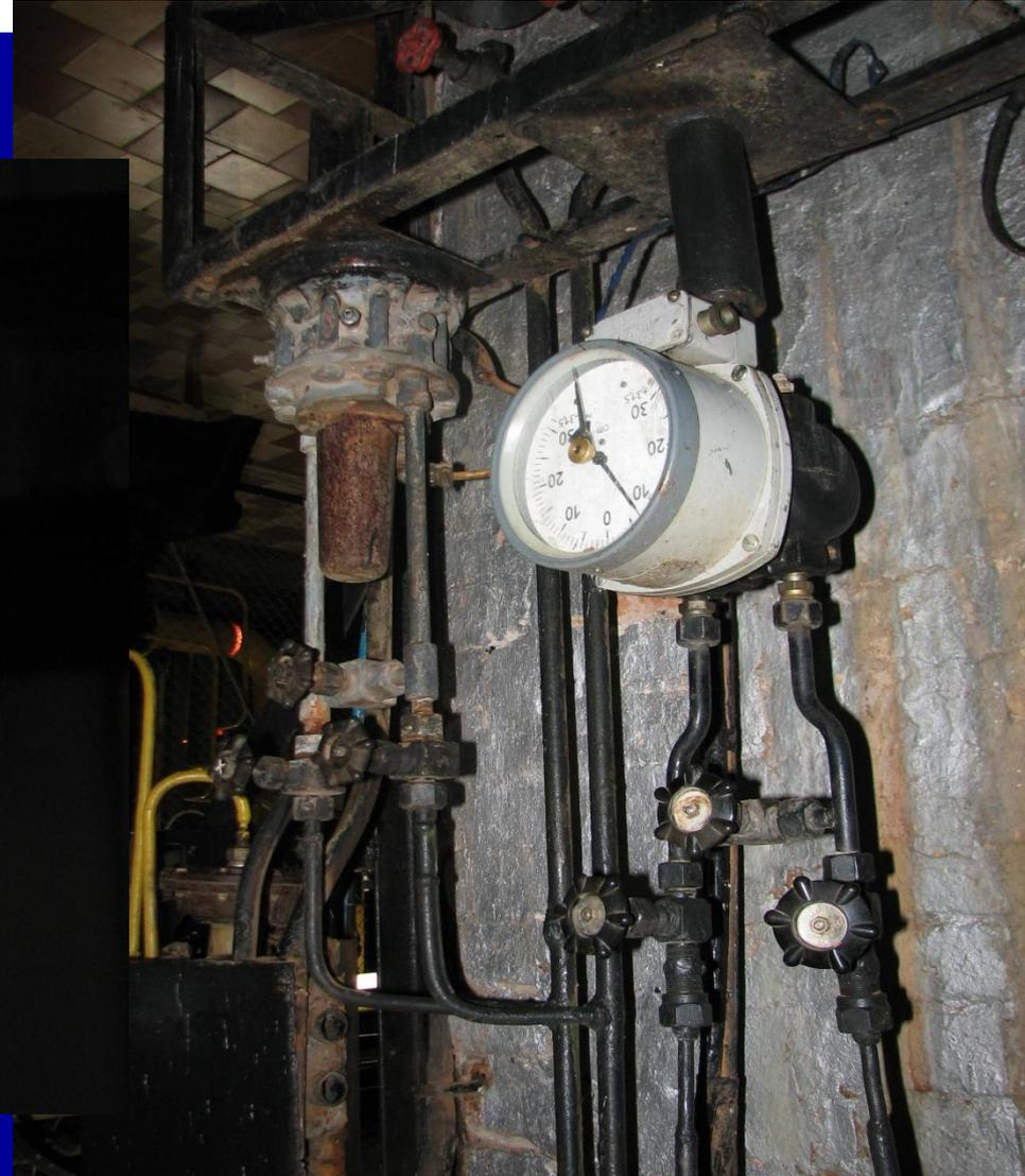
Для наблюдения за уровнем воды в котле устанавливают два водоуказательных прибора.
