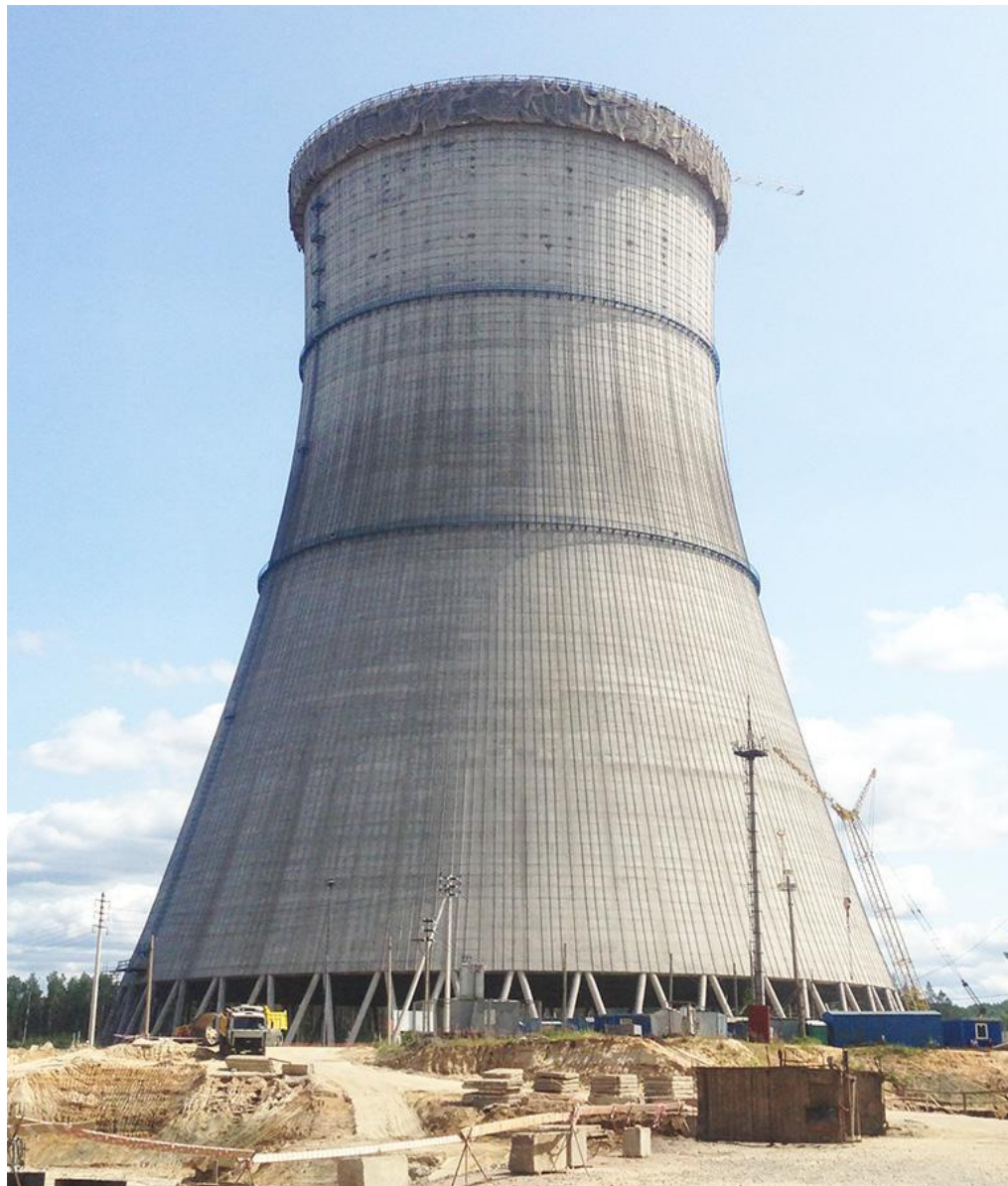
Градирня Ленинградской АЭС
