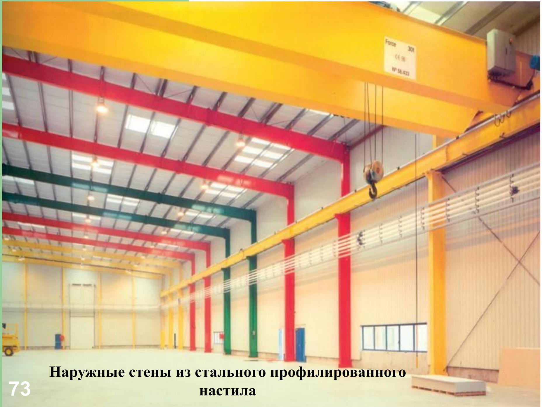
**Наружные стены из стального профилированного настила**
