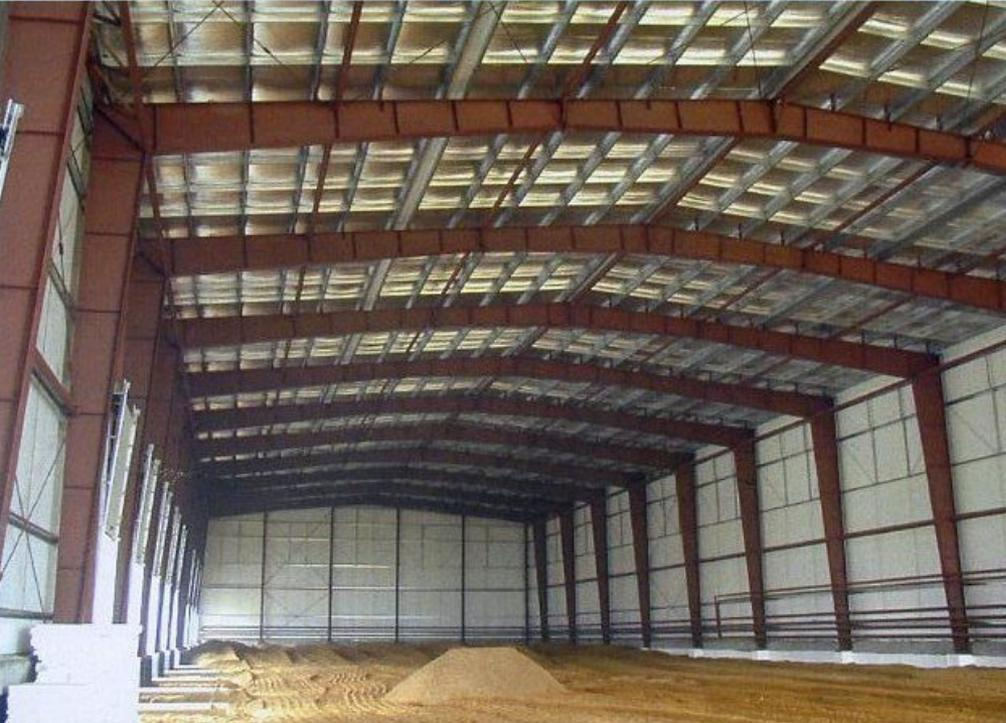
Помимо основных в здании предусматривают **фахверковые колонны**, предназначенные для крепления стен. Их устанавливают в торцах здания и между основными колоннами крайних продольных рядов при шаге колонн 12 м и длине стеновых панелей 6 м.
