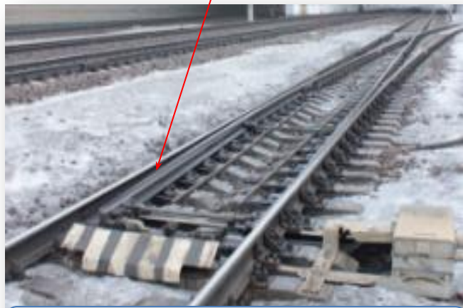
Износ рабочей поверхности острьяка и рамного рельса
