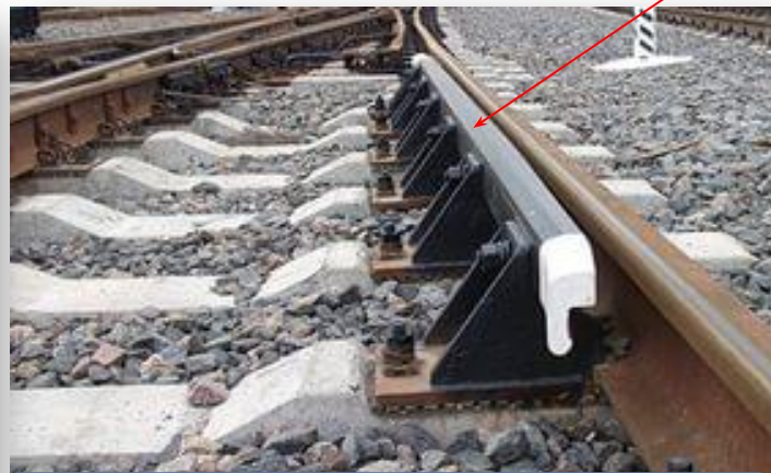
Износ боковой рабочей поверхности контррельса
