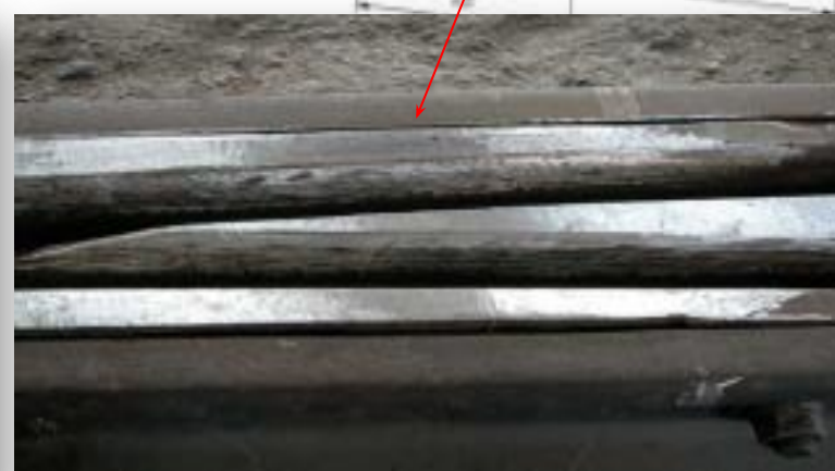
Износ поверхности катания литых усовиков и сердечника крестовины
