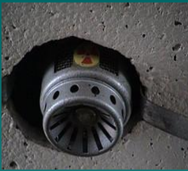
Радиоизотопный дымовой извещатель КИ-1
