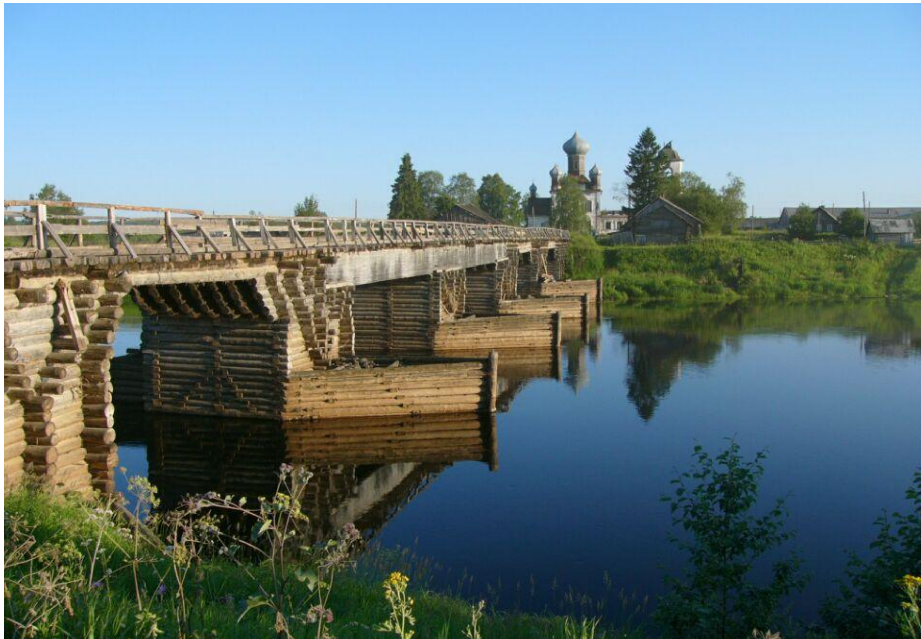
Пятипролетный ряжевой мост на р. Кене
