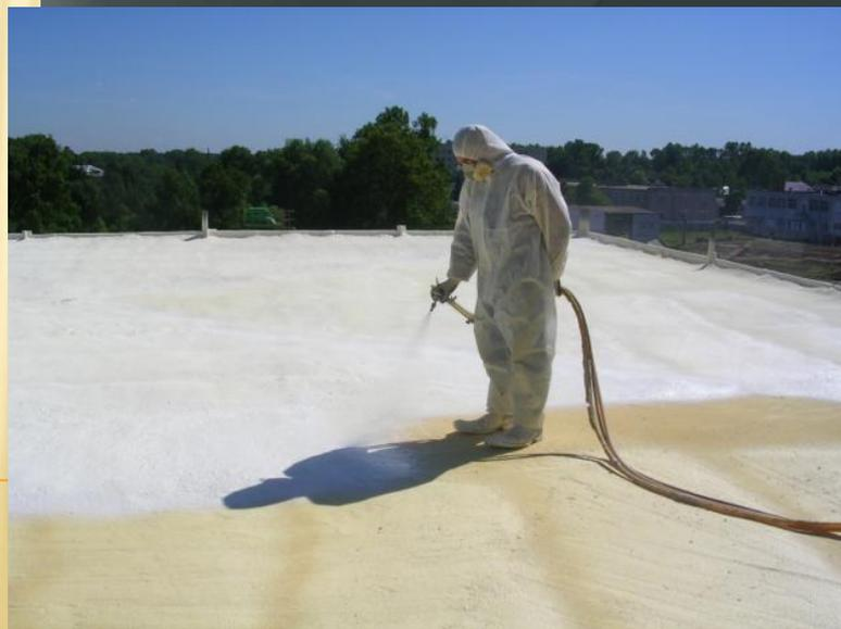
Как и в случае с изоляцией монолитных плоских крыш, **изоляция плоских крыш из профнастила** является одним из традиционных способов применения ППУ. Кровли складов, производственных помещений, выставочных и спортивных залов, как правило, изготовлены из профилированных металлических листов и имеют сравнительно большие пролеты. Эти легкие кровельные конструкции требуют изоляции легкими материалами, чтобы иметь возможность выдерживать дополнительные нагрузки из-за ветра, дождя и снега.
