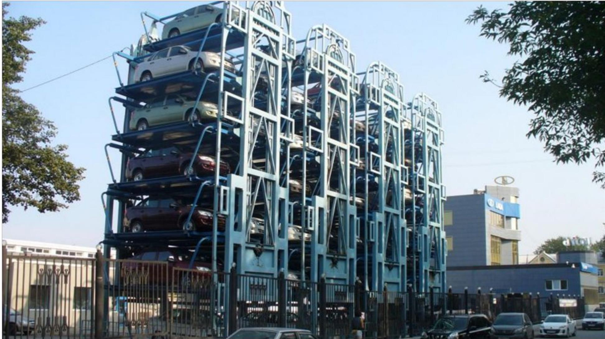
Рисунок 1.2 – МАП роторного типа
