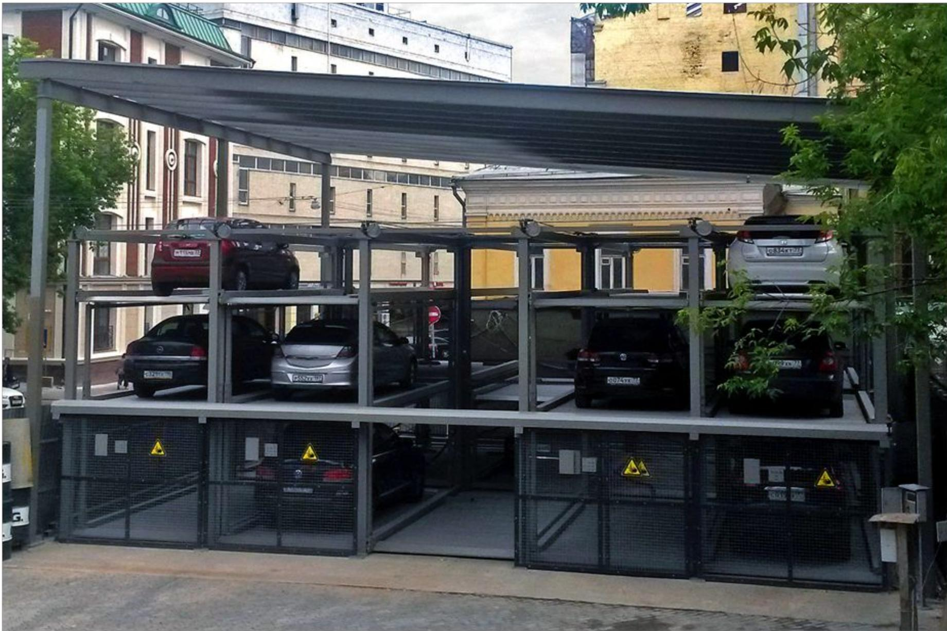
Рисунок 1.3 – МАП пазлового типа
