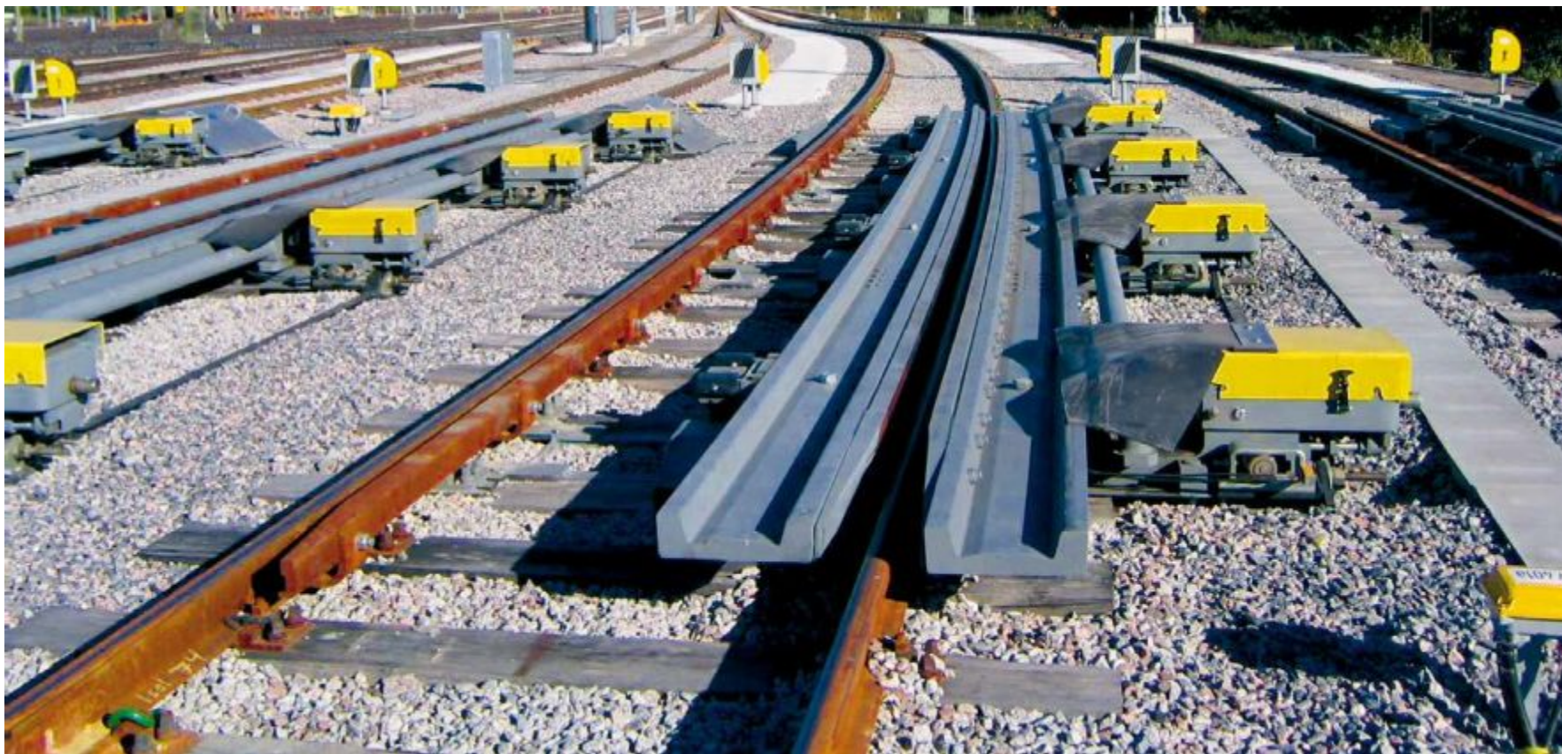
Однорельсовый рычажный фрикционный тормоз конструктивного типа TW-E в закруглении пути
