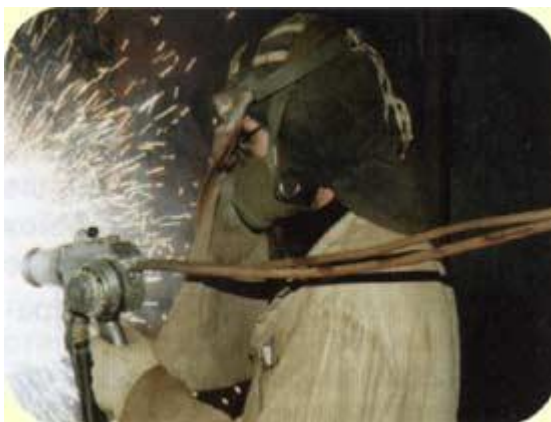
Нанесение алюминиевого ЭМП на стенку нефтяного резервуара
