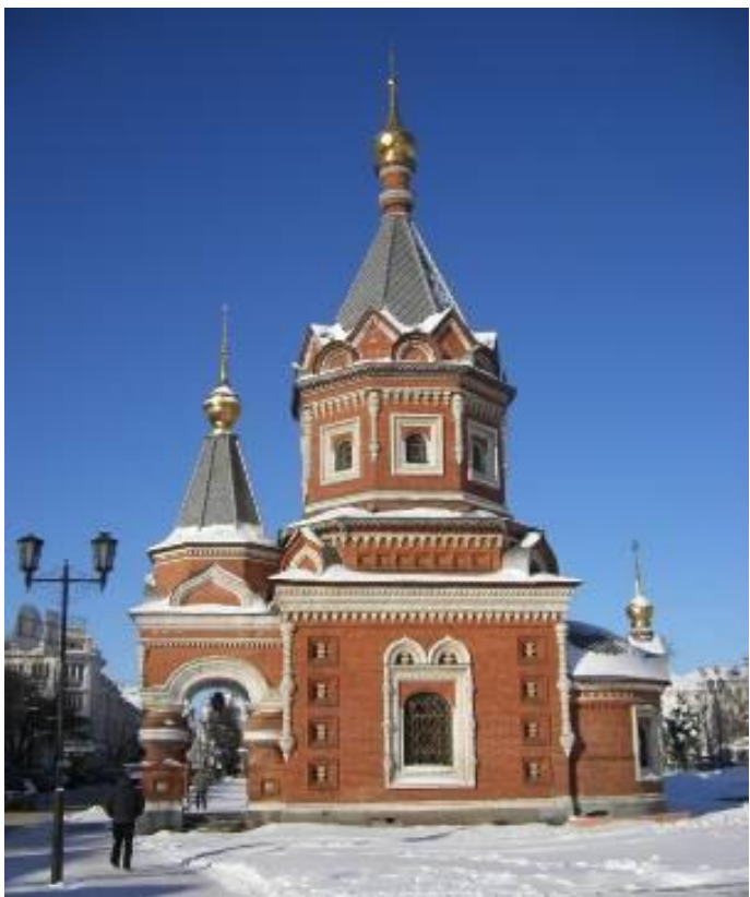
Часовня Александра Невского в Ярославле. Возведена в 1892 году по проекту Н.И. Поздеева
