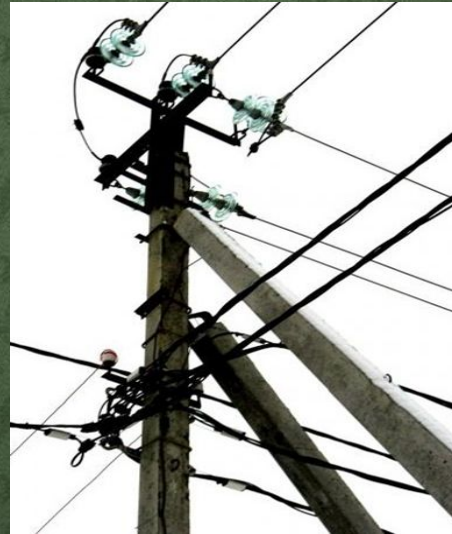
Воздушная линия электропередачи 10 кВ
