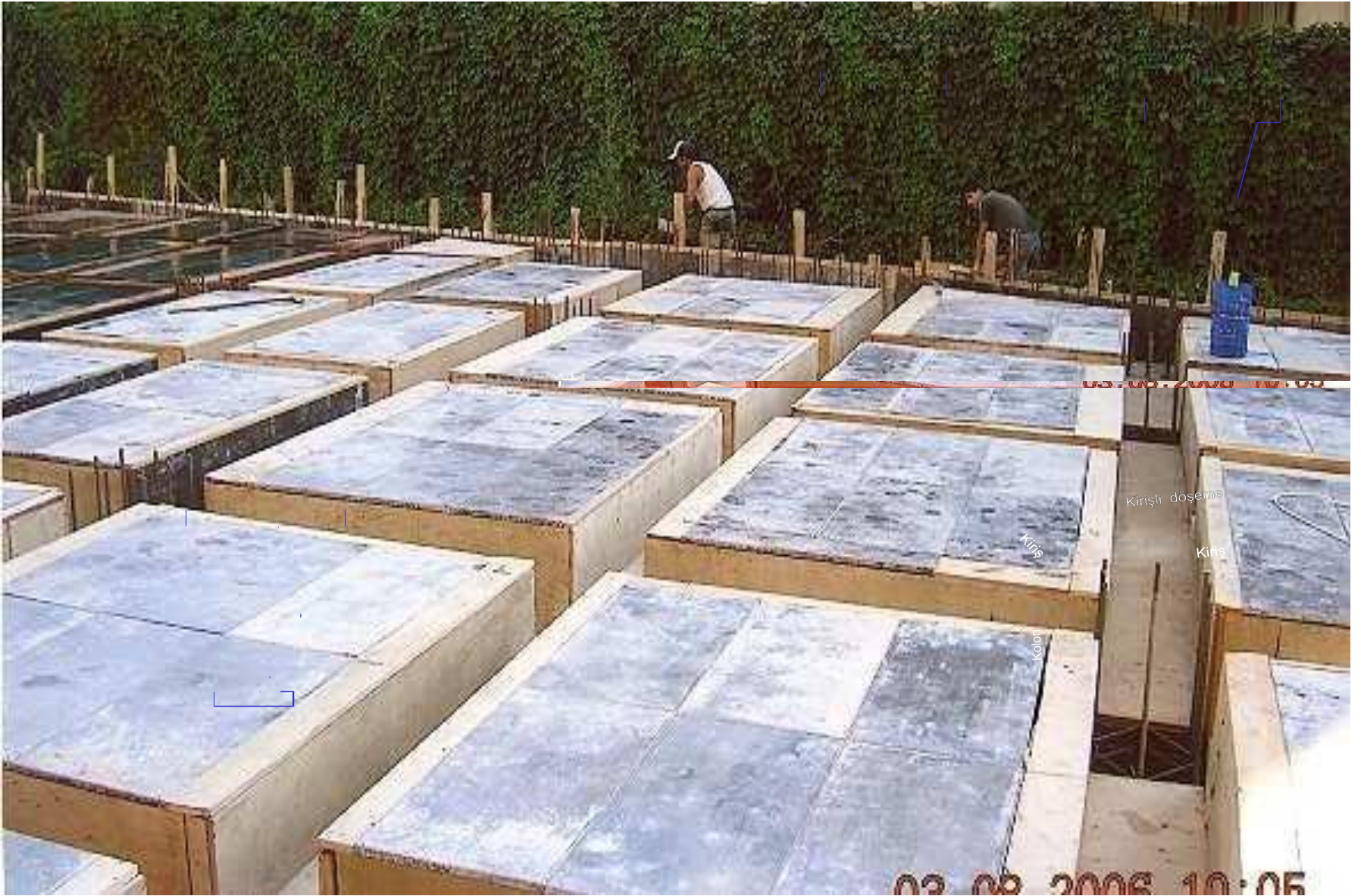
Kiriş-döşeme kalıbı hazırlanıyor
