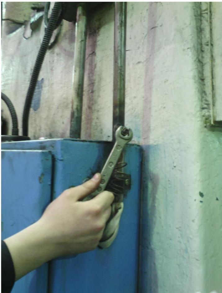
Произвести протяжку заземления на электросиловой разводке
