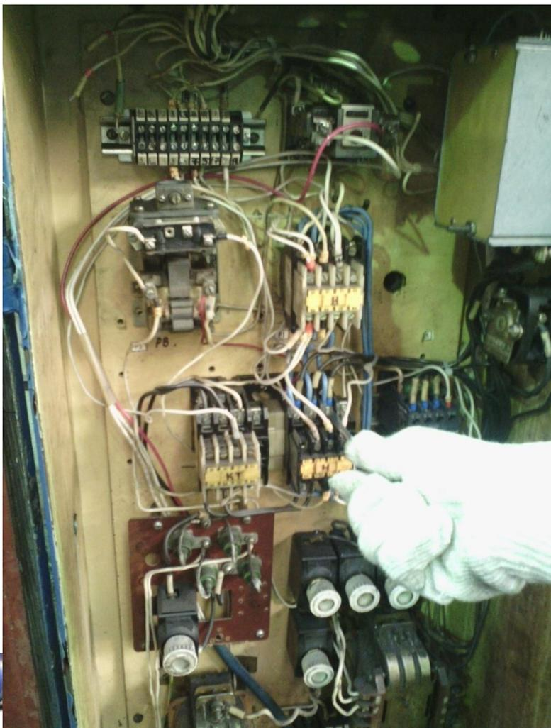
**Произвести чистку контактов электро-аппаратуры от нагара, протяжку винтовых соединений, проверку крепления.**
