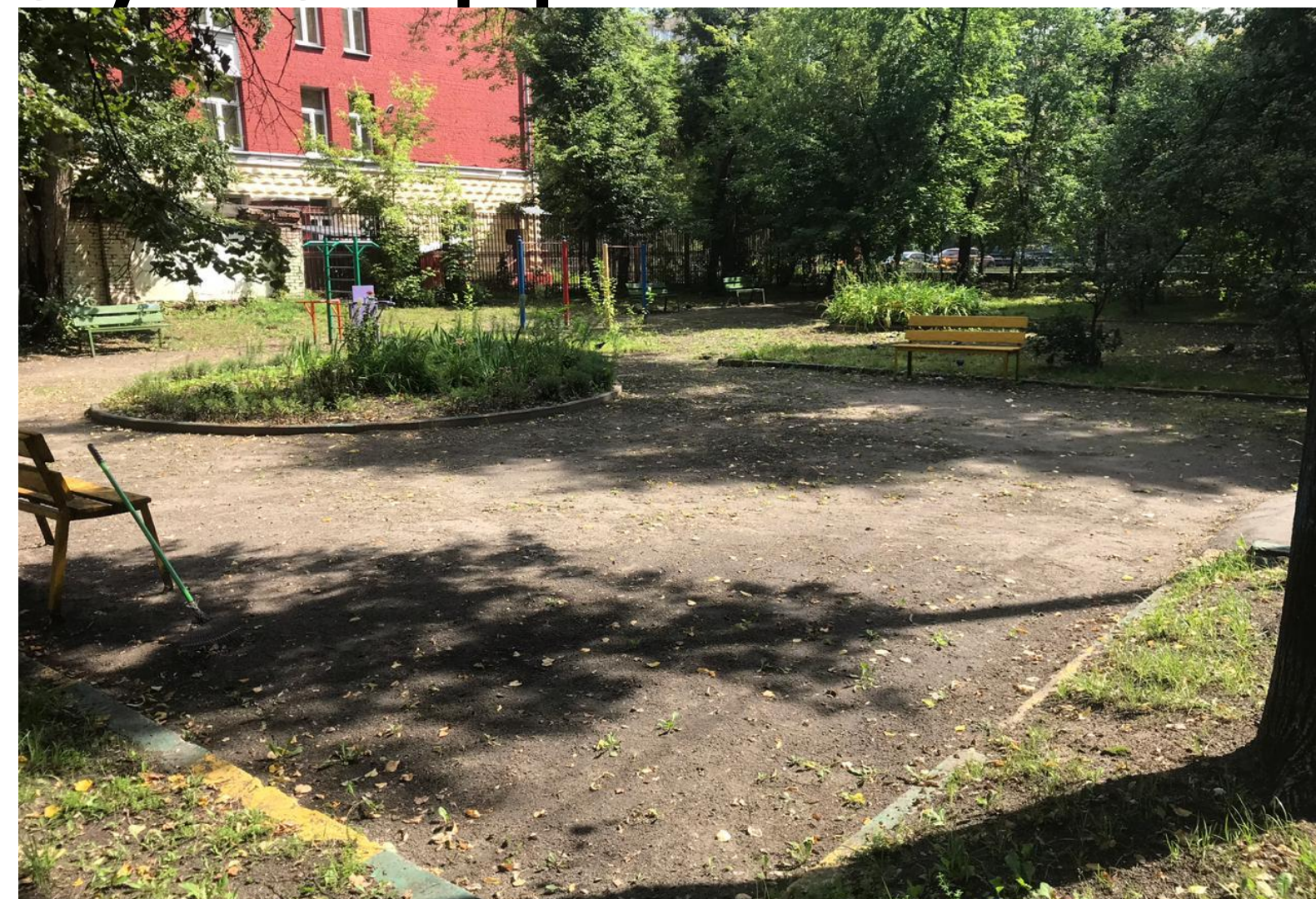
Устройство детской площадки
