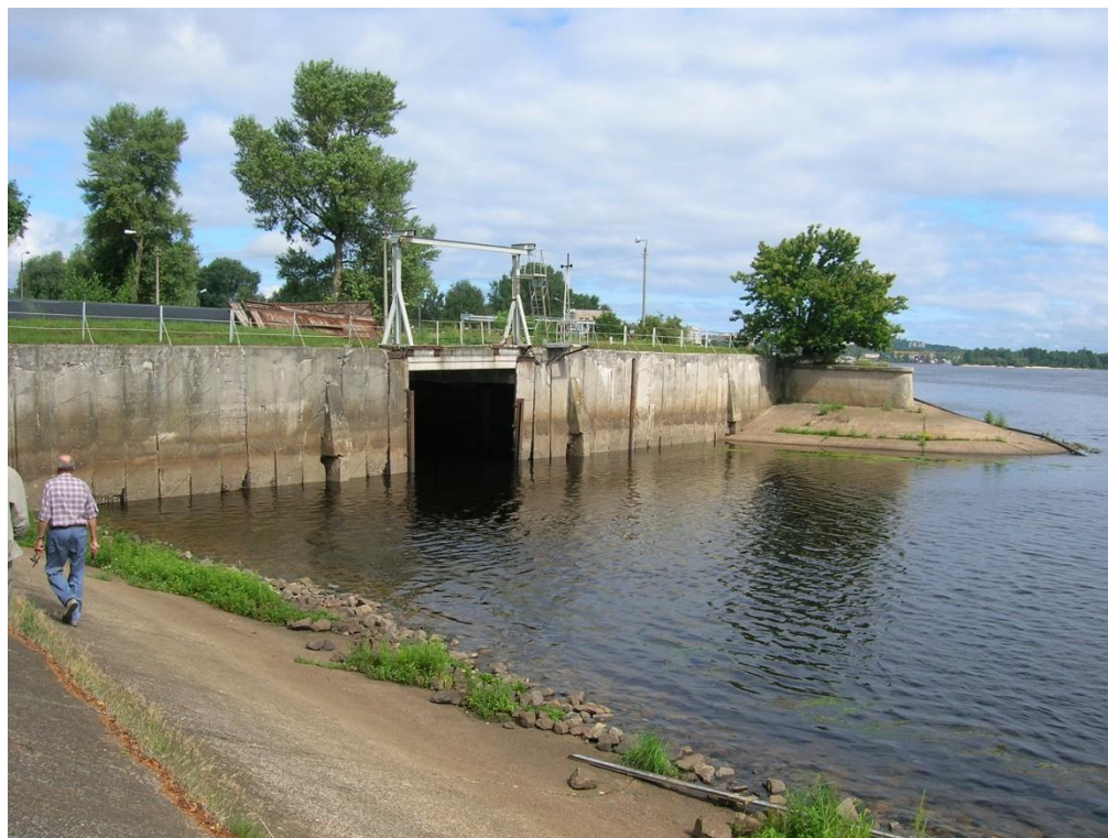
Рис. 4. Загальний вигляд входу до водозабірної ковша №1
